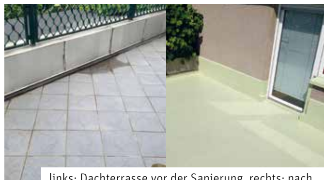
links: Dachterrasse vor der Sanierung, rechts: nach der Sanierung erstrahlt die Terrasse im neuen Glanz
