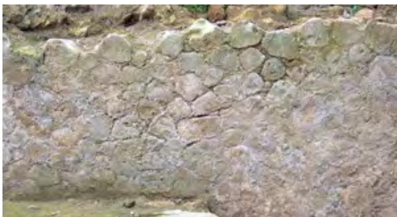
▲ Fig. 6. Muro construido con opus reticulatum .
