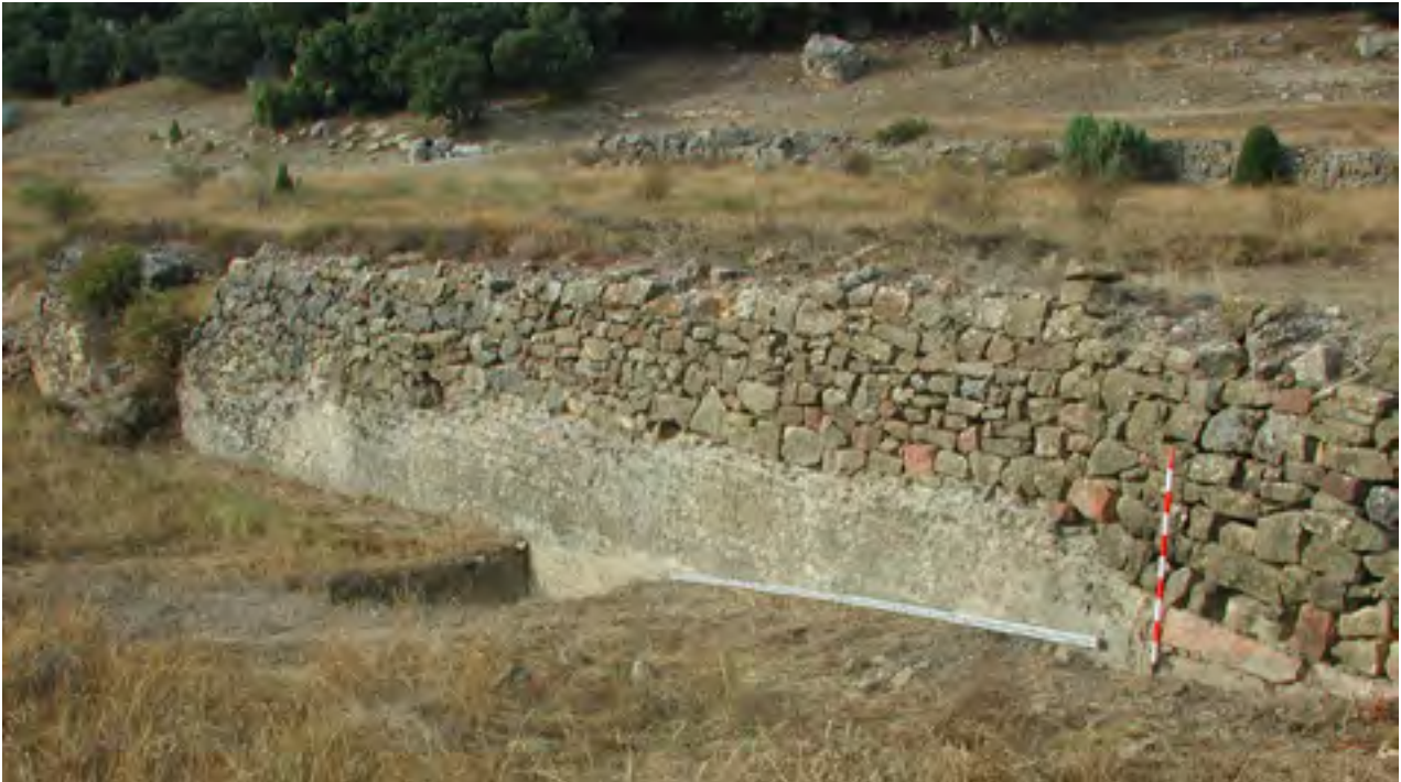
▲ Fig. 7. Tramo septentrional de opus caementicium del muro de contención de la terraza central junto al sondeo núm. 2.
