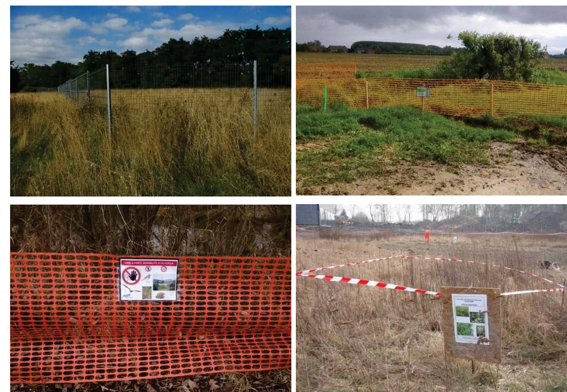
Illustration n°28. Différents types de balisages de zones sensibles en bordure des emprises à mettre en place avant les travaux. © Biotope
