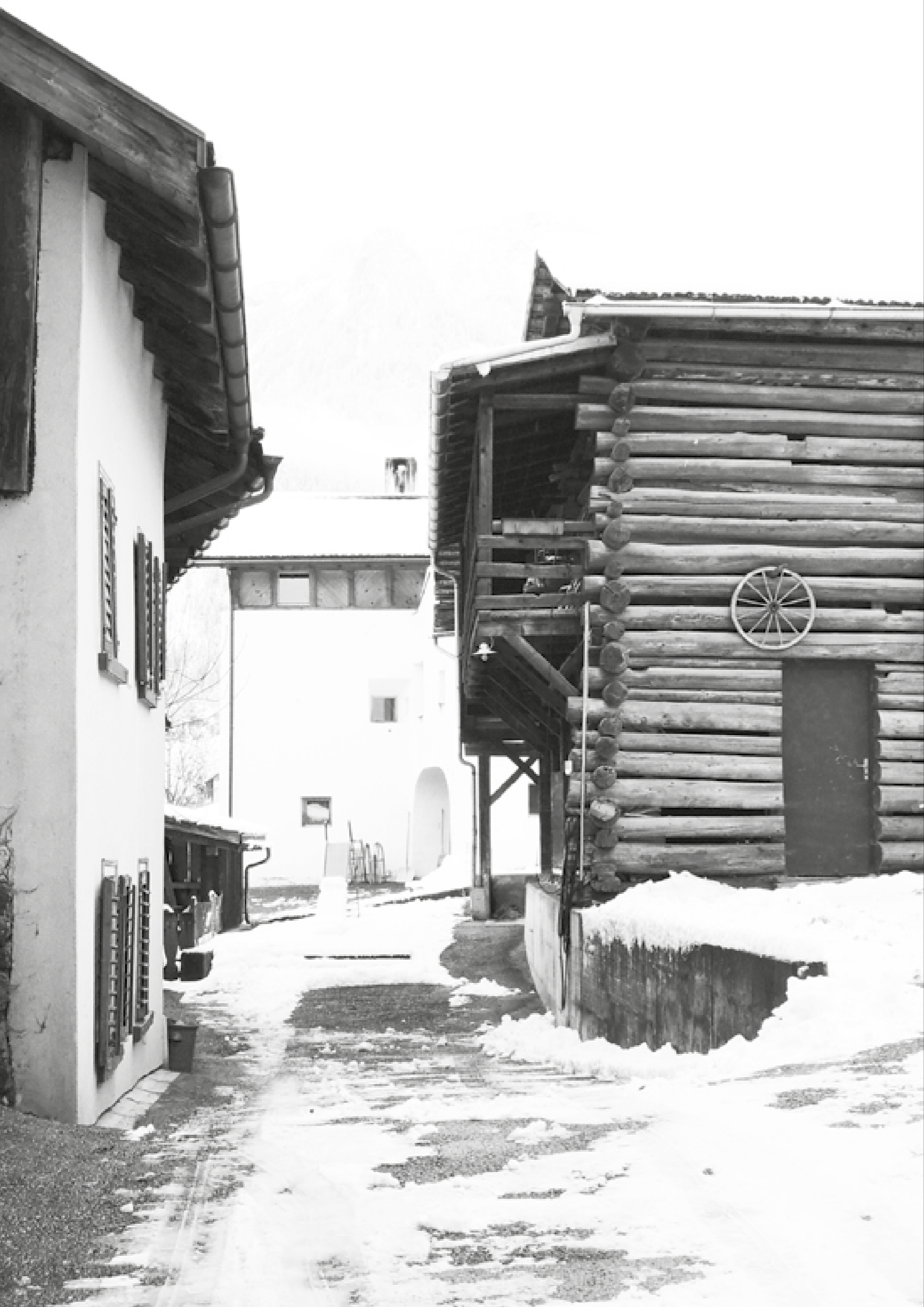
Gassenraum zwischen Wohnbauten und Ställen auf privaten Parzellen werden teilweise als Fusswege genutzt.
