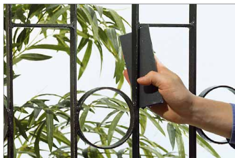
5 Sie haben es befürchtet? Nachdem auch der Voranstrich getrocknet ist, wird wieder geschliffen
