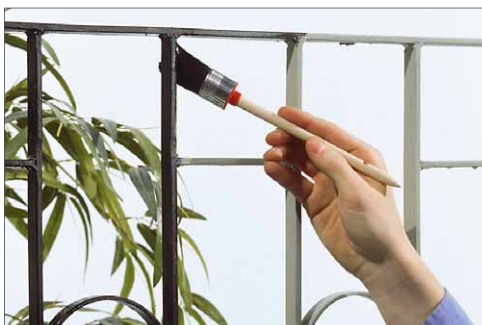
4 Nach dem Abtrocknen des Schutzanstriches wird der Voranstrich aufgebracht, der gleiche Lack wie der Endanstrich
