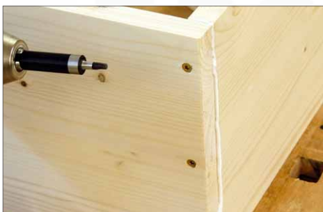
6 Die Schrauben sorgen für den nötigen Anpressdruck, damit der Leim die Hölzer verbindet
