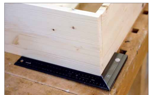
2 Der Aufbau beginnt mit dem unteren Rahmen. Das erste Seitenteil wird im rechten Winkel an ein Holz für die Stirnseite angelegt
