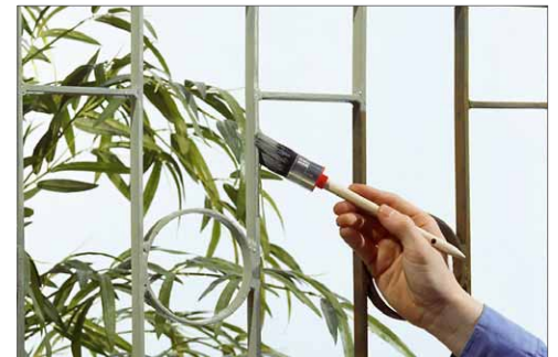
3 Das Geländer wird nun mit Rostschutzgrund vorbehandelt, der auf den späteren Lack abgestimmt ist. Er erfüllt den gleichen Zweck wie die inzwischen nicht mehr verwendete Bleimennige
