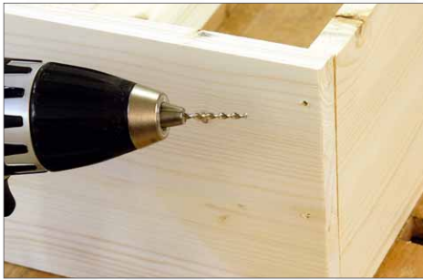
3 Sind die Bretter exakt ausgerichtet, werden die Löcher für die Schrauben vorgebohrt (3 mm). Hier ist ein zweites Paar Hände hilfreich
