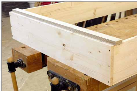
8 An den auf Übermaß geschnittenen Auflageleisten wird die benötigte Länge angezeichnet und die Leisten passend abgesägt, so dass sie exakt zwischen die Seiten des Bettkastens passen
