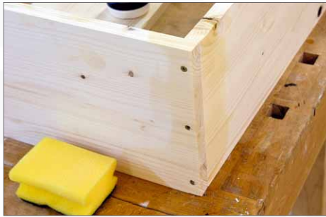
7 Den überquellenden Leim schnell feucht wegwischen, dann passiert nichts – auch nicht auf der Arbeitsfläche. Auf diese Weise wird der Rahmen des Bettkastens komplett verleimt
