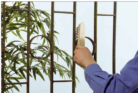
1 Hier bitte nicht halbherzig mit der Drahtbürste umgehen. Jede entfernte Roststelle verlängert die Lebensdauer der Lackierung
