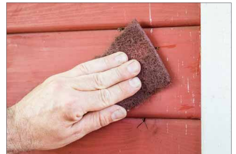
Bei unregelmäßigen Oberflächen ist Schleifvlies eine gute Alternative zu Schleifpapier
