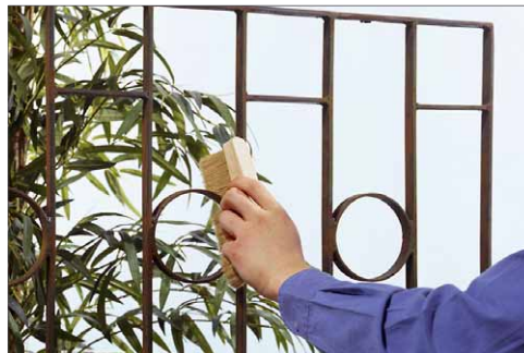
2 Die Reinigung hat reichlich Metallstaub hinterlassen. Mit einer weichen Bürste oder einem Handfeger kann er leicht entfernt werden
