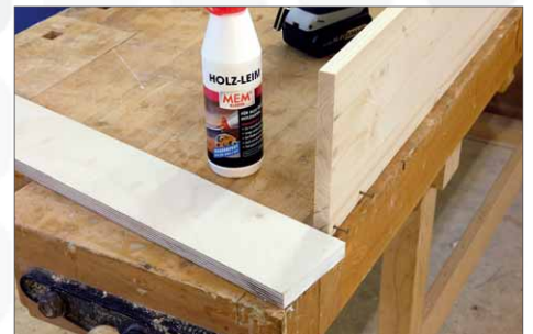
13 Der obere Rahmen wird im Prinzip genauso gebaut. Hier habe ich nur mit den Rahmenaufgaben begonnen. Das Vorgehen ist das gleiche wie oben: Exakt positionieren, vorbohren, senken, Leim angeben, Schrauben eindrehen, überschüssigen Leim wegwischen
