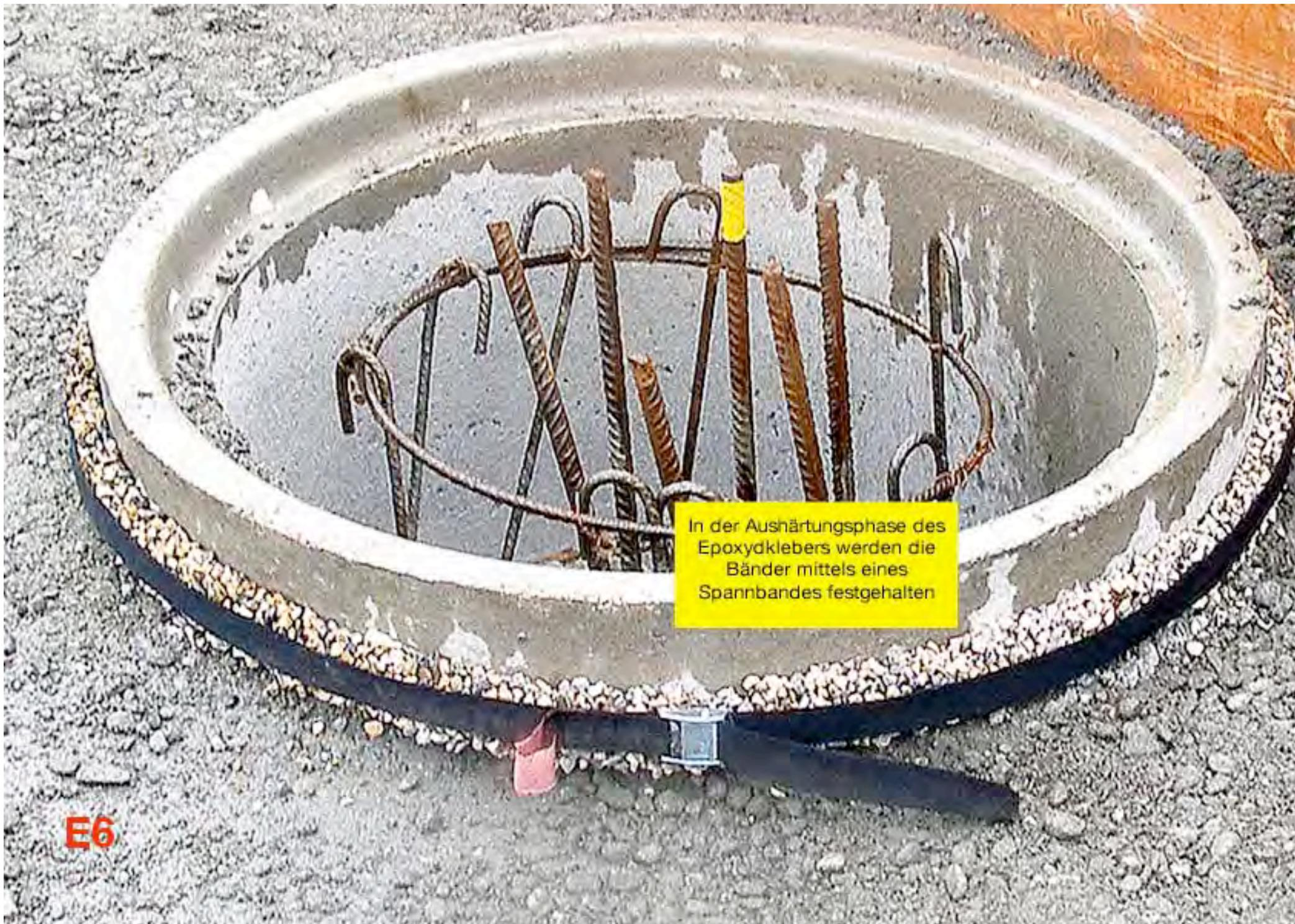
In der Aushärtungsphase des Epoxydklebers werden die Bänder mittels eines Spannbandes festgehalten
