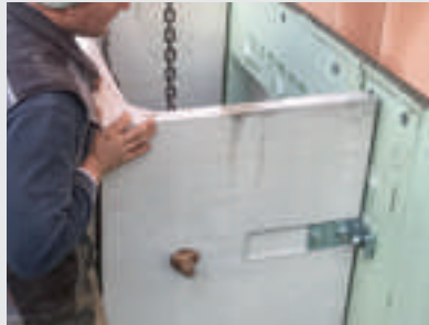
Einhängen des Lichtschachtes an die Dübel
