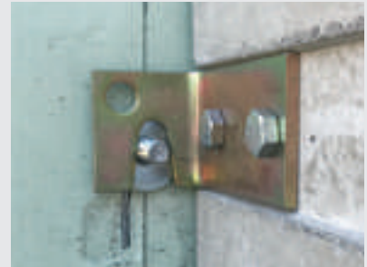
Vorteil: Dämmung im Bereich des Haltewinkels muss nicht ausgeschnitten werden!
