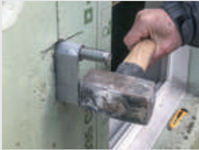
Einschlagen des Befestigungselements
