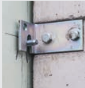
Einhängen des Lichtschachts an die Dübel
