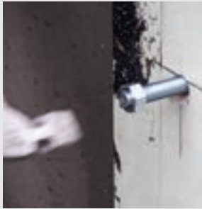
Schwerlastdübel bis zur Hälfte in Betonwand einschlagen
