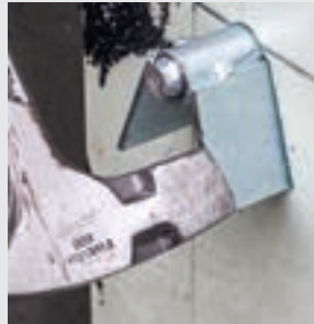
Einschlagen des Befestigungselements
