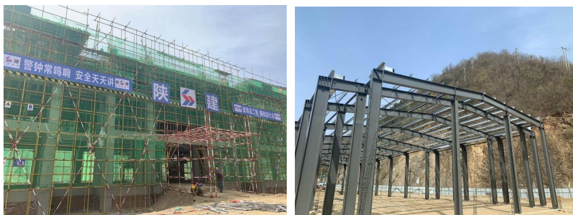
图 2.13-8 鱼类增殖放流站现场建设情况图
