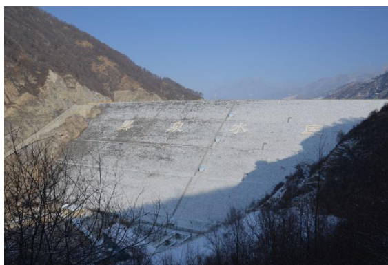
冬季的水库大坝
