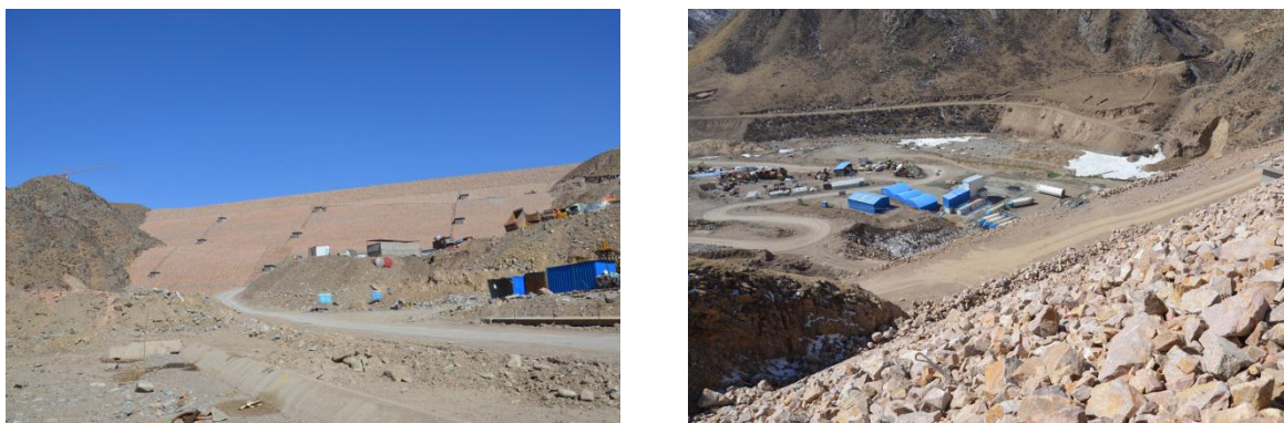
图 2.3-6 石头峡水库现场施工图(2014年3月)
