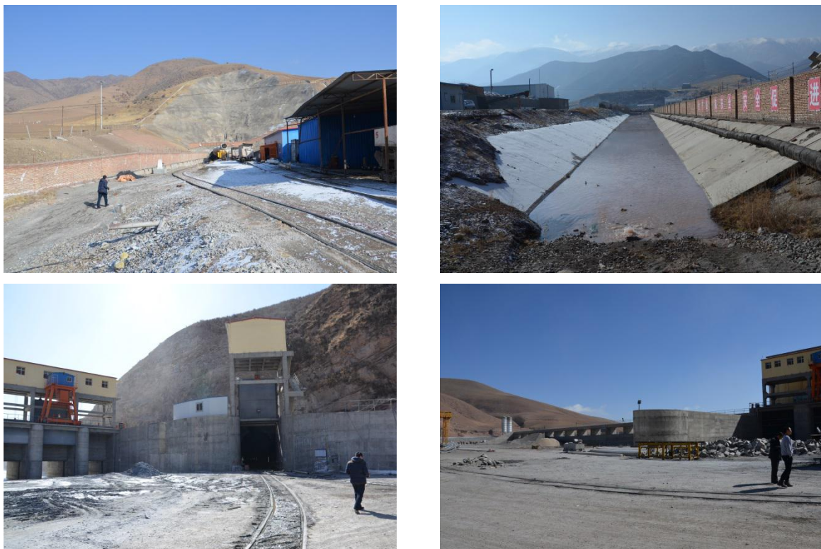
图 2.3-5 调水总干渠施工现状图(2015 年 3 月)
