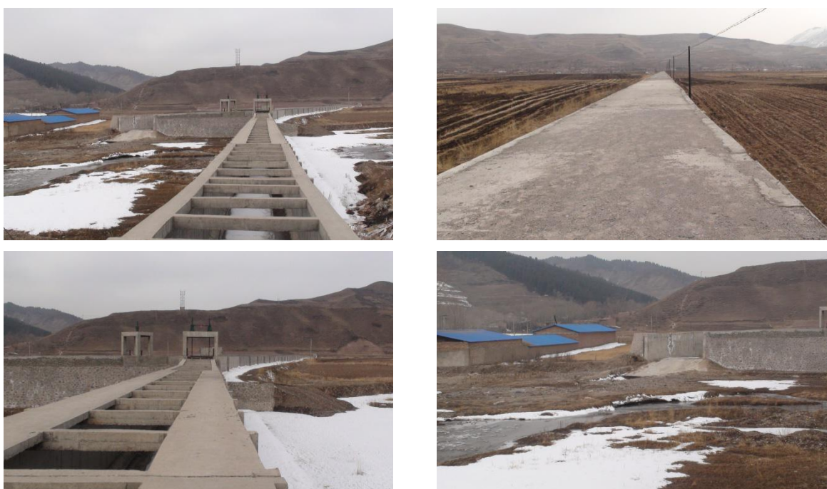
图 2.3-3 北干一期现状图(2015年3月)
