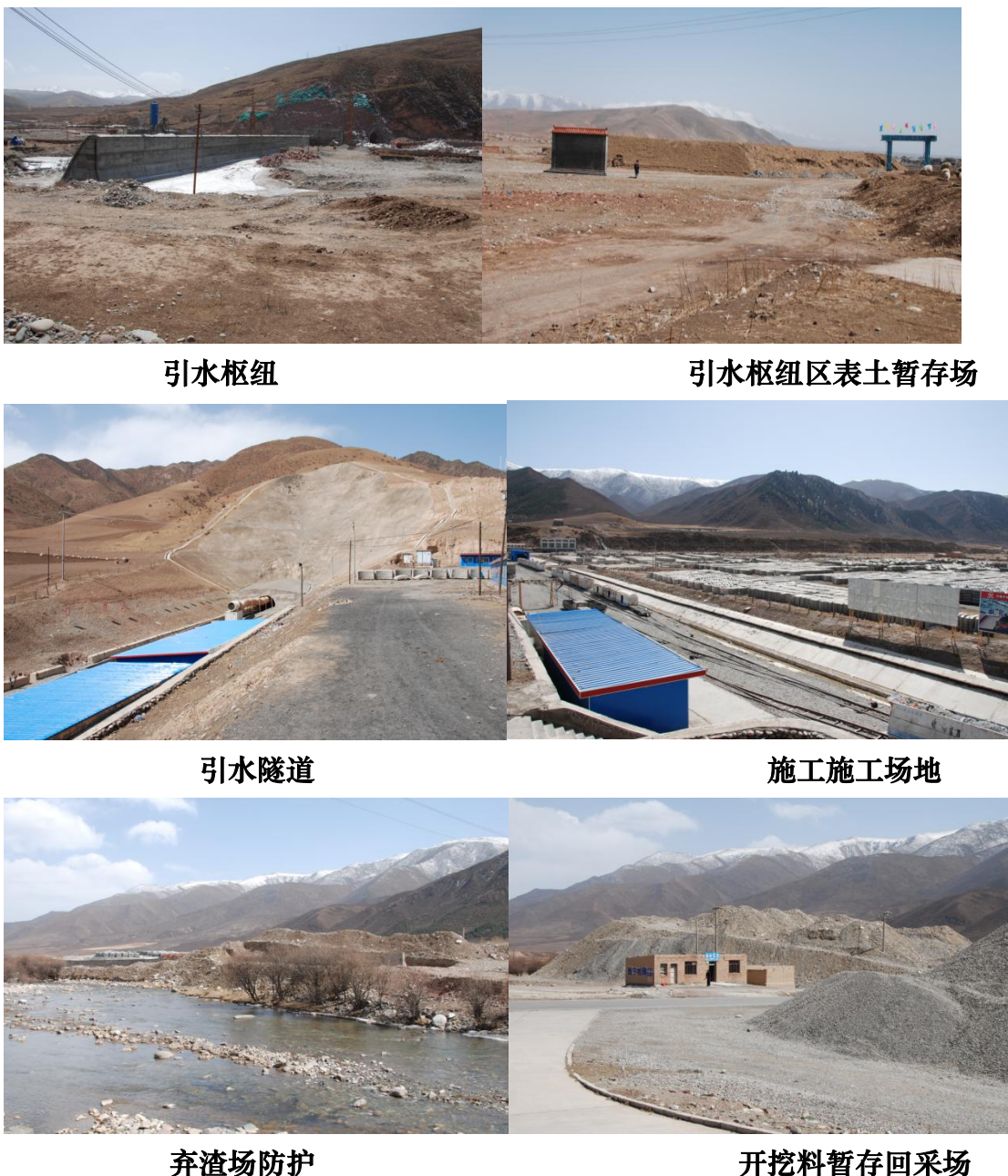
图 2.3-4 调水总干渠施工面貌图
