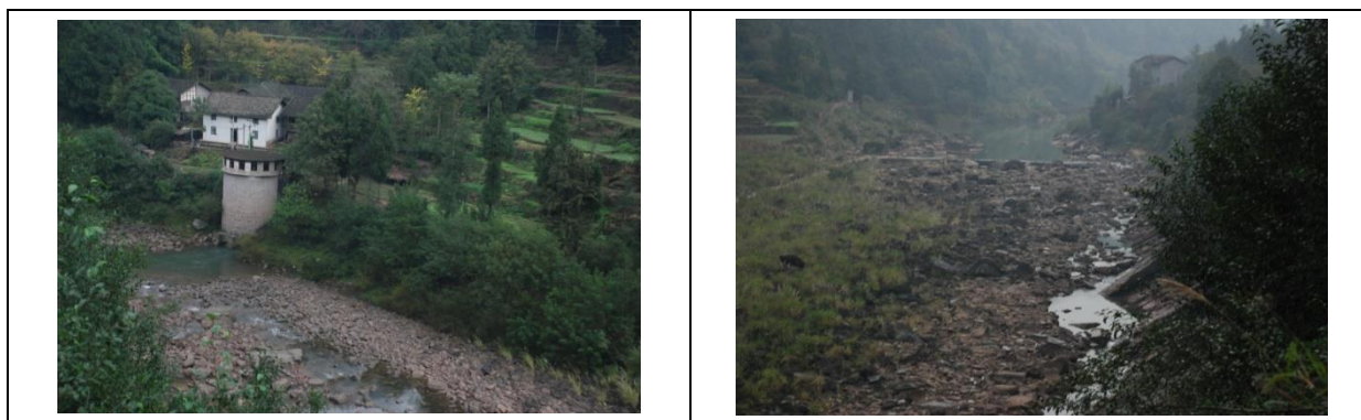
江家口水库坝上-秦河电站减水河段
