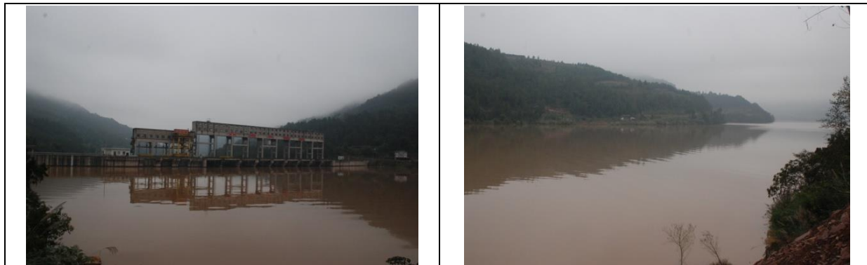
江家口水库坝下-双滩水电站闸坝及库区
