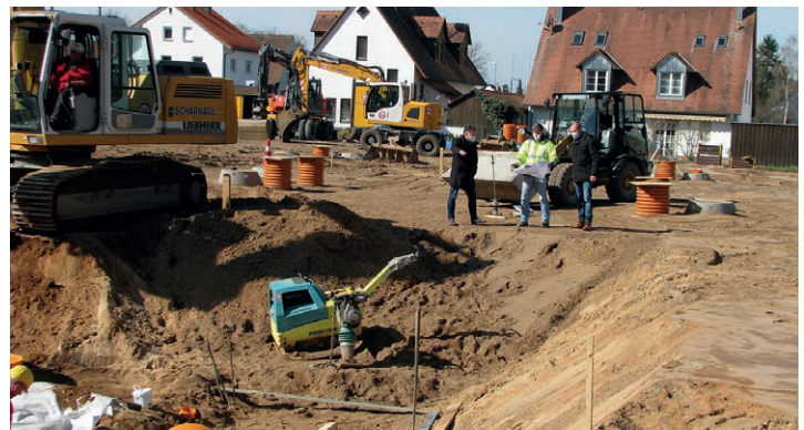
Die Erschließung des kleinen Baugebietes bei Sorg geht gut voran, wie Wendelsteins Bürgermeister Werner Langhans bei einem Ortstermin feststellen konnte. Die Verlegung des Schmutz- und Oberflächenwasserkanals ist fast abgeschlossen.
