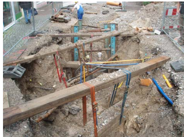
Kanalbau Kuttelgasse (beengte Verhältnisse)
