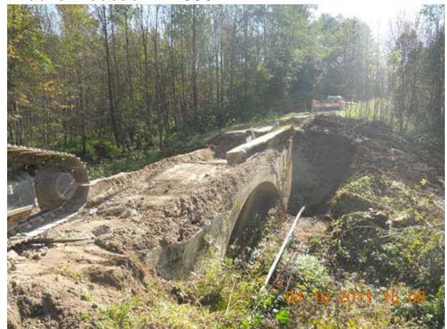
Abbruch alte Bogenbrücke „Legauer Bahn“
