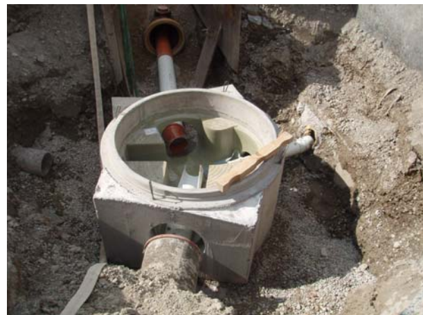
Kanal Hirschgasse West (Schachtunterteil)
