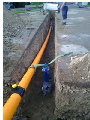
Leitungserneuerung Im Kalker Feld
