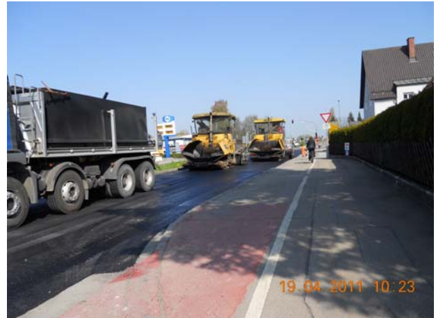
Deckensanierung Donaustraße Ampelbereich
