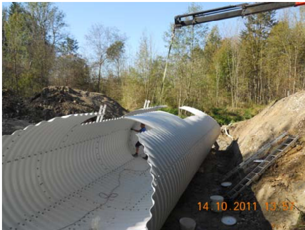
Zusammenbau des Stahlblechdurchlasses
