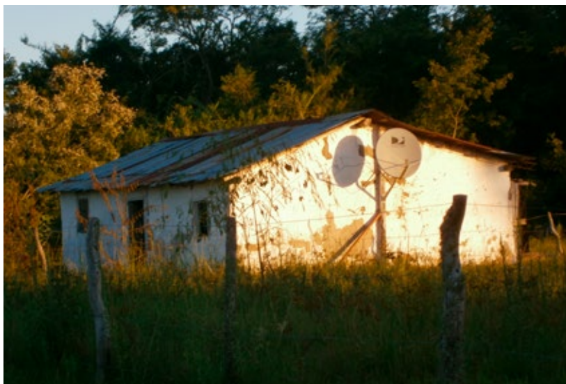
Figura N° 1. Vivienda tradicional en C. Carlos Pellegrini
