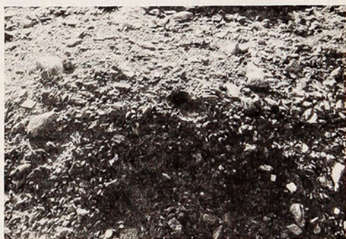
Figura 5. Orificio de escape de aire de uno de los volcanes de asentamiento
