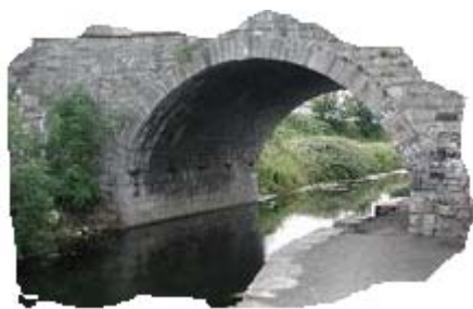
Brougham Bridge en medio de Broombridge Road, Dublín.
