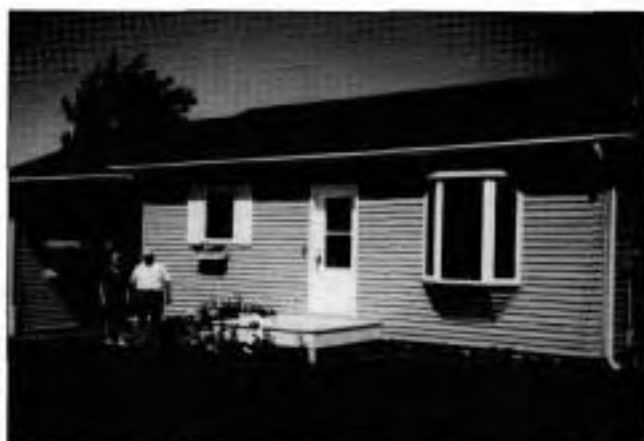
Résidence actuelle construite en 1992
