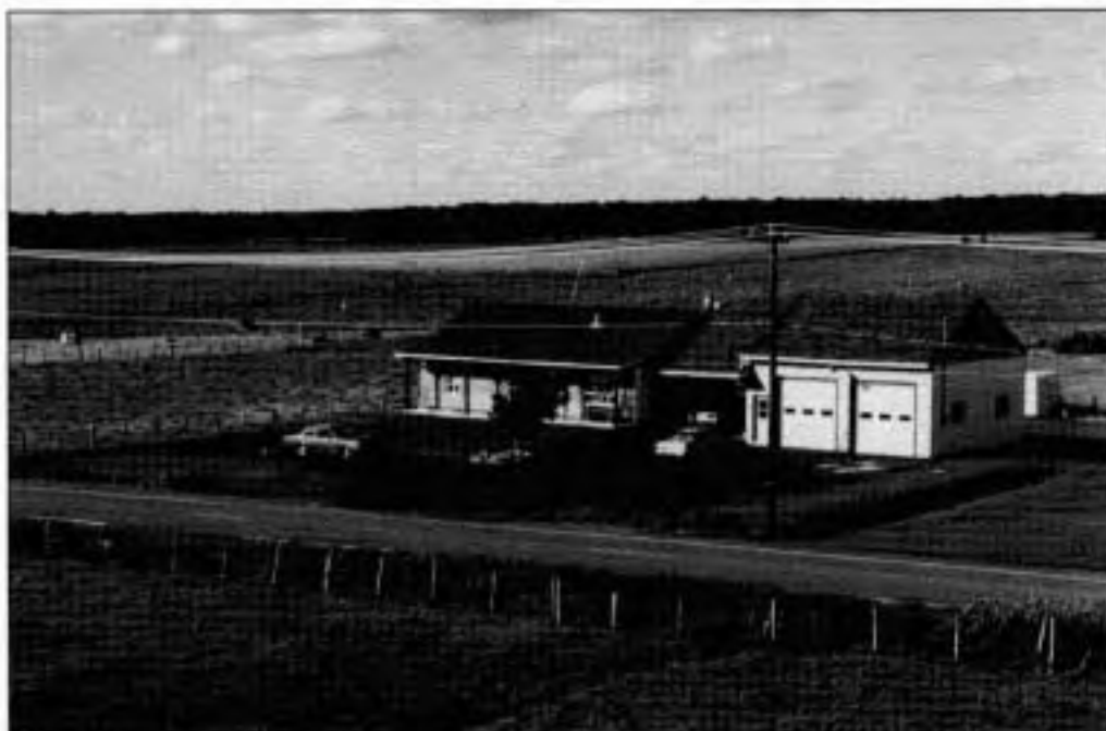
Maison familiale avec GARAGE PIERRE VALLÉE
