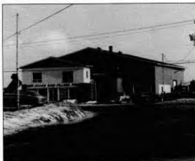
Garage de l'entreprise: EXCAVATION BOIS-FRANCS, INC.
