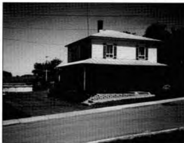
Résidence sise au 29 Landry
