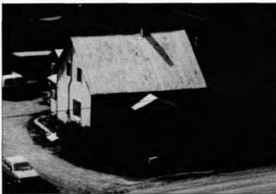
Maison avant les rénovations extérieures
