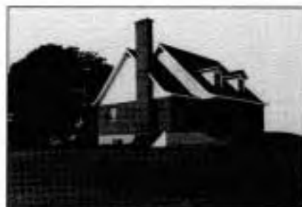
Propriété de Réal Labbé et d'Irène Landry, construite en 1978 au 131, chemin Laurier, Norbertville
