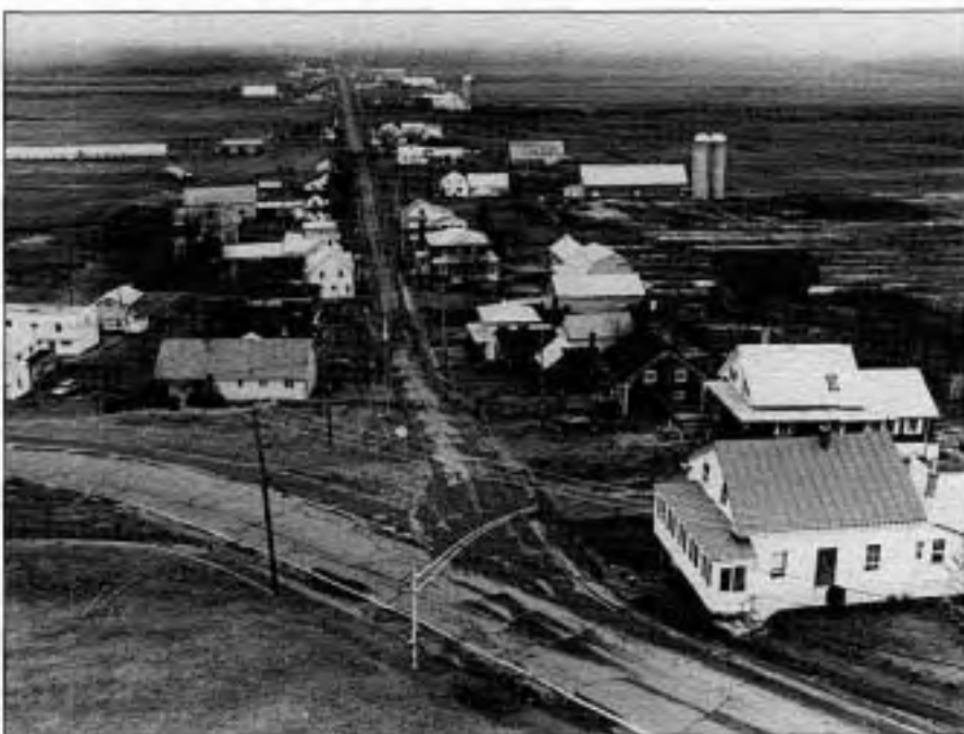
La rue Landry après l'abaissement de la "côte" et le changement de la courbe
