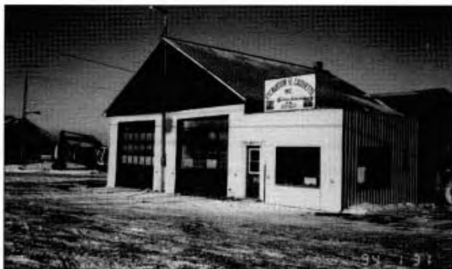
Garage actuel EXCAVATION G. CAOUCETTE inc.
