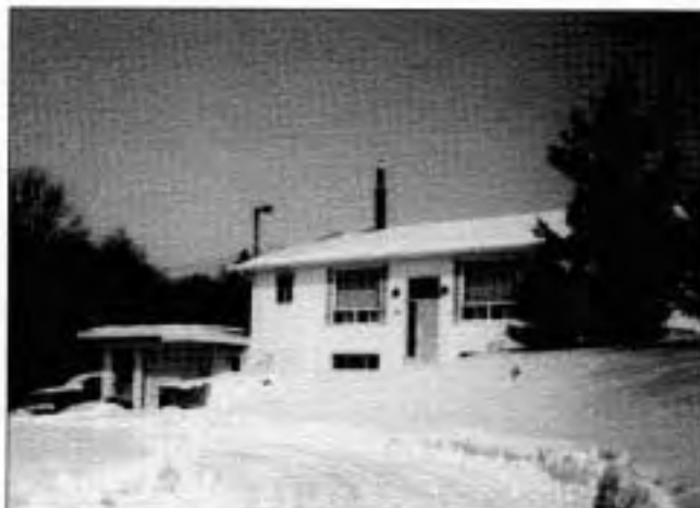
Propriété de Diane Landry sise au 160, 5e rang Norbertville, construite en 1976
