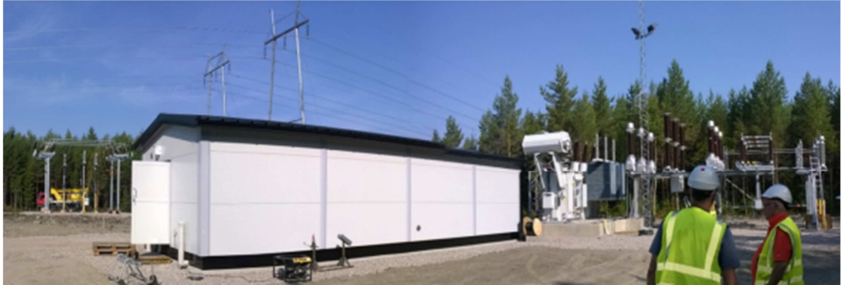
Kuva 13 Esimerkki rakenteilla olevasta tuulivoimapuiston sähköasemasta.
