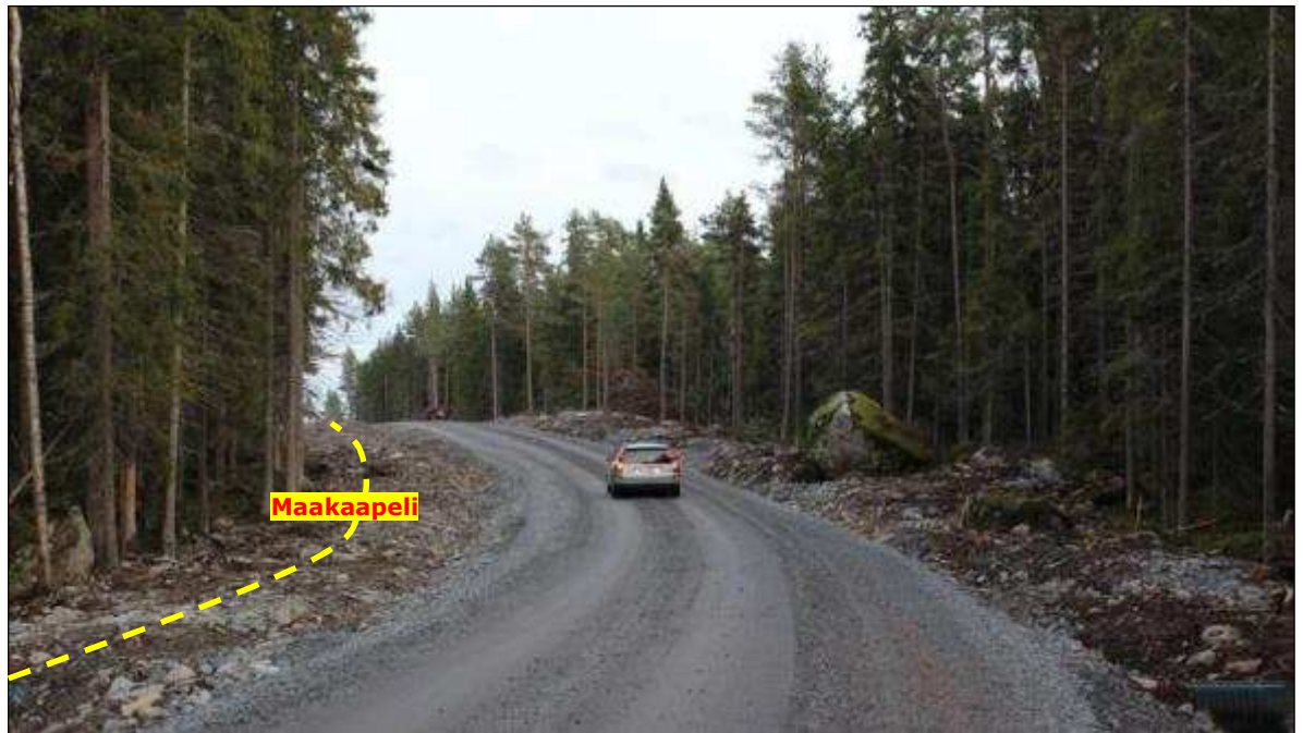
Kuva 11 . Esimerkki tuulivoimapuiston rakennus- ja huoltotiestä. Teitä käytetään muun muassa betonin ja soran sekä voimaloiden komponenttien kuljetuksiin. Tuulivoimapuiston käyttövaiheessa teitä käytetään mm. vuosittaisissa huolloissa. Maakaapelin oja on sijoitettu tien vasemmalle puolelle.
