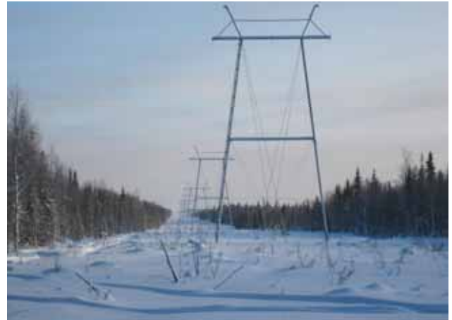
Kuva 10. Rakenteilla oleva 220 kV voimajohto Keulakkopään kohdalla
