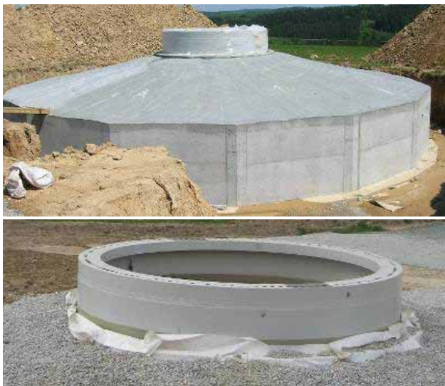
Kuva 6. Tuulivoimalan perustuksen maanvarainen betonilaatta rakennusvaiheessa
