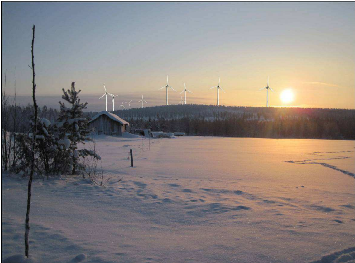
Kuva 7. Näkymä Palsselän tieltä (kohde 26) vaihtoehdossa VE1. Etäisyys tuulipuistosta 1,6 km. Tuulivoimaloiden väriä on korostettu esitysteknisistä syistä.
