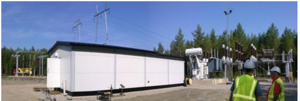
Kuva 14 Esimerkki rakenteilla olevasta tuulivoimapuiston sähköasemasta.
