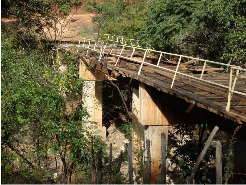
PONTE QUEBRADA SOBRE O Córrego Tamandua
