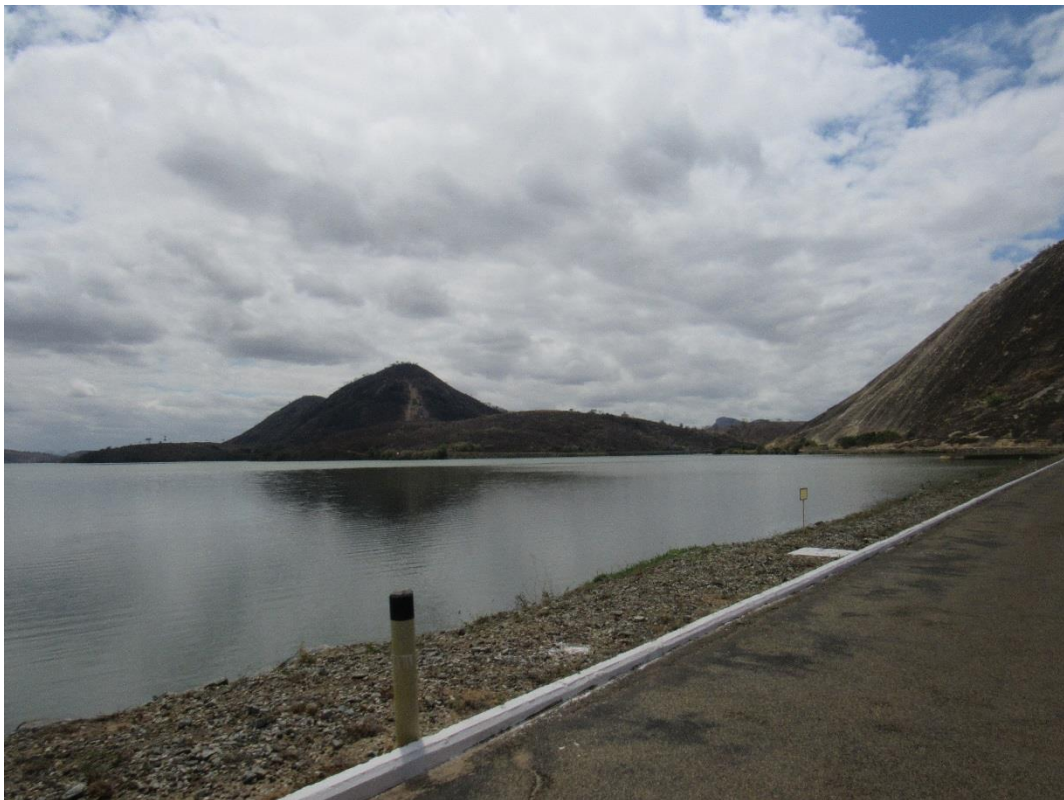
MARGEM DA BARRAGEM DE AIMORÉS
