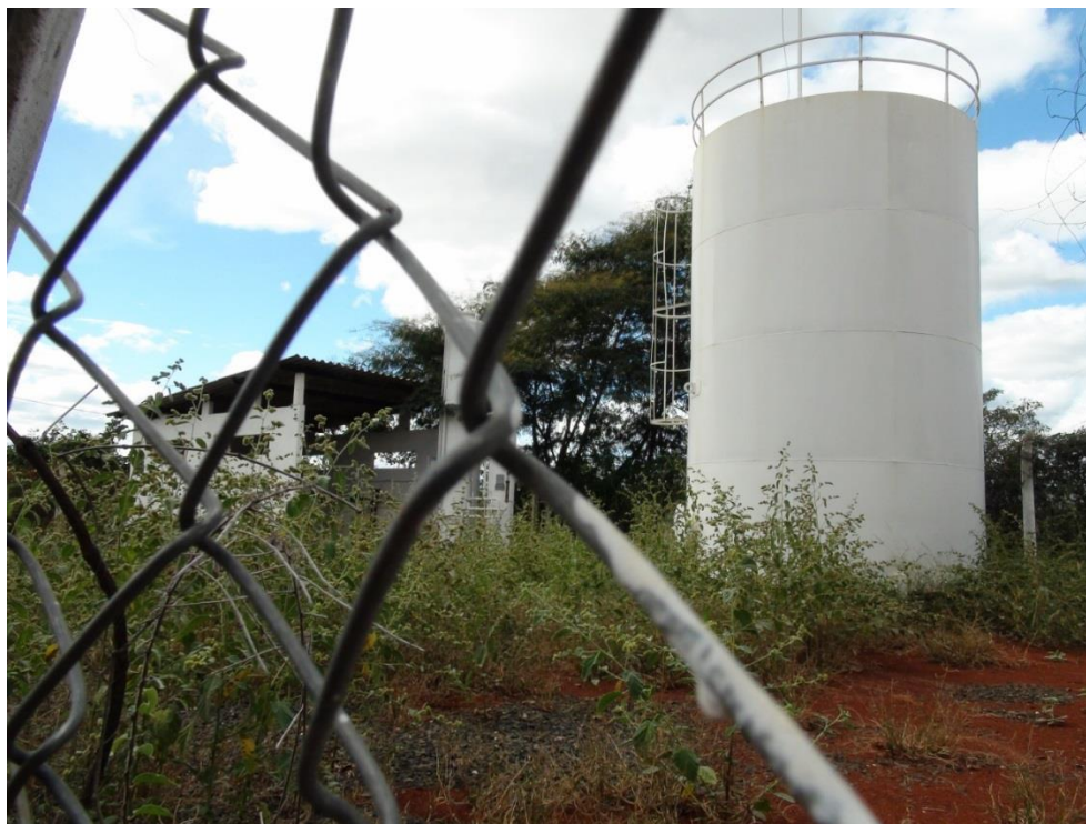
ESTAÇÃO DE TRATAMENTO DE ÁGUA DA AGROVILA I COBERTA POR MATO
