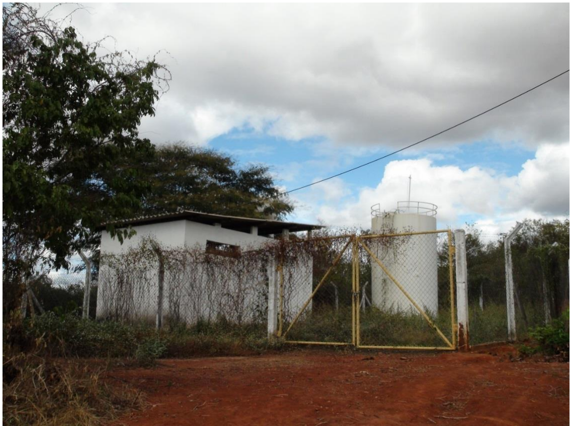
ESTAÇÃO DE TRATAMENTO DE ÁGUA DA AGROVILA I
