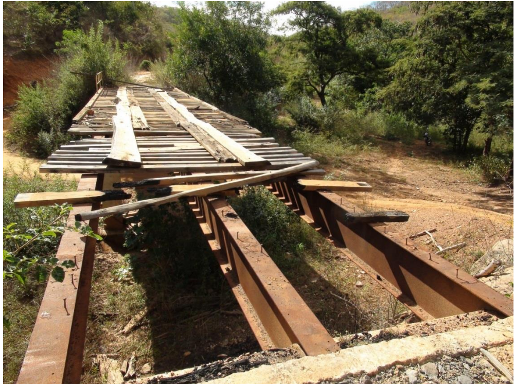
PONTE QUEBRADA SOBRE O Córrego Araça
