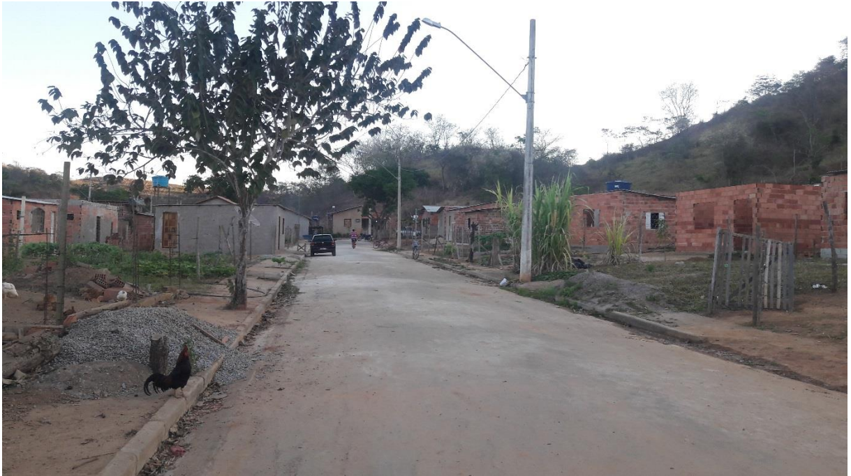
OCUPAÇÃO CONDOMÍNIO ITUETA – 45 FAMÍLIAS MORAM NO LOCAL OCUPADO SEM ACESSO À ÁGUA, ESGOTO E COLETA DE LIXO
