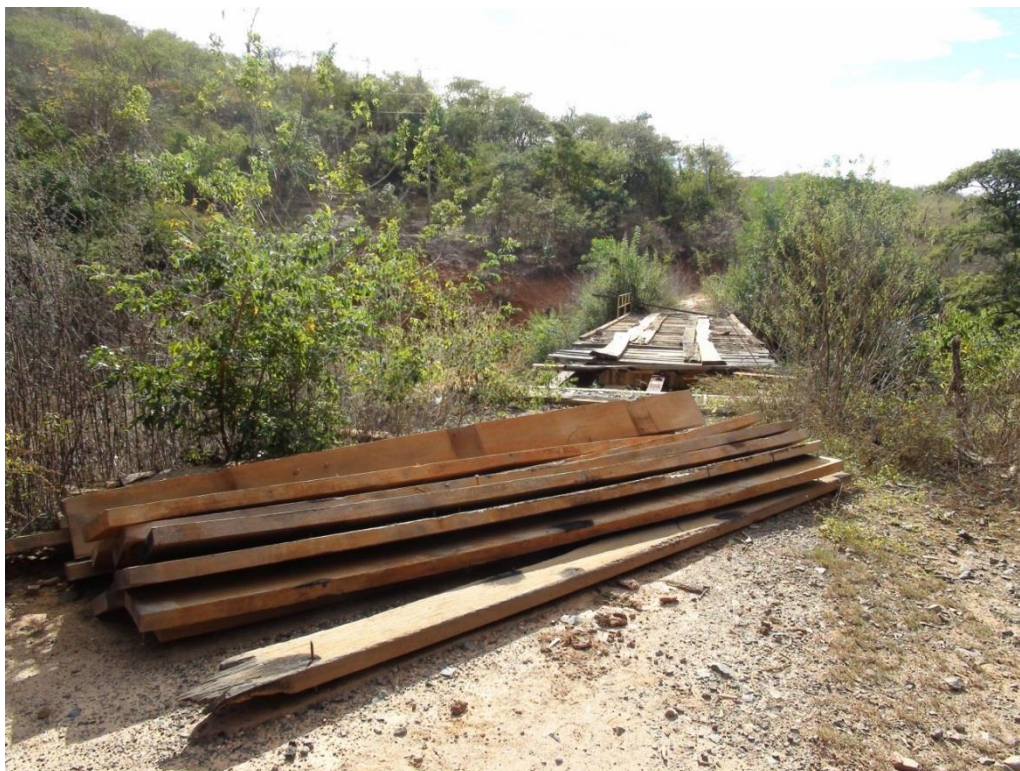
TÁBUAS COLOCADAS PELOS MORADORES PARA FAZER A REFORMA DA PONTE – CÔRREGO ARAÇÁ
