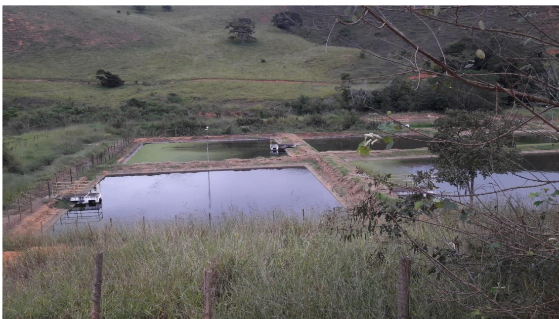
ESTAÇÃO DE TRATAMENTO DE ESGOTO – ETE
