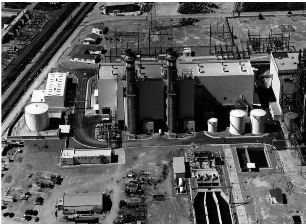
Figura 1.11. Central térmica de ciclo combinado de Castellón (por cortesía de UNESA).
