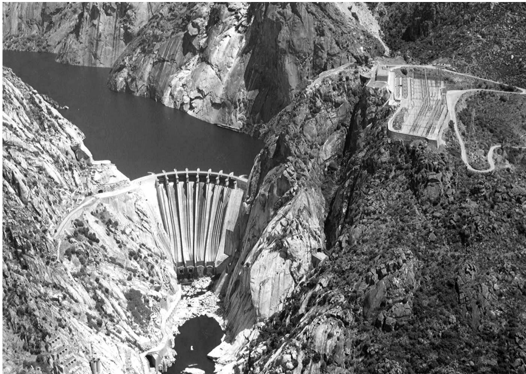
Figura 1.4. Tipos de presas: (arriba) de gravedad, central de José M o de Oriol, Cáceres, y (abajo) de bóveda, central de Aldeadávila, Salamanca (por cortesía de UNESA).
