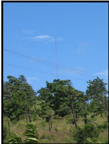
Anemometer in Nueva Arcadia
