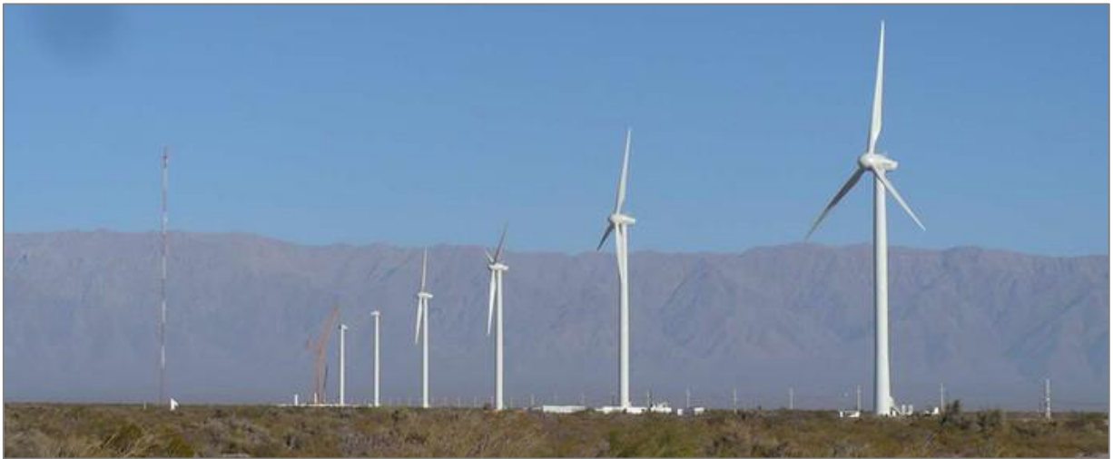
Vista de un parque eólico tipo en Argentina 28
