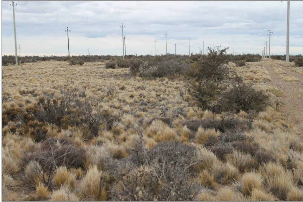
Foto 15. Transecta G, líneas eléctricas.
