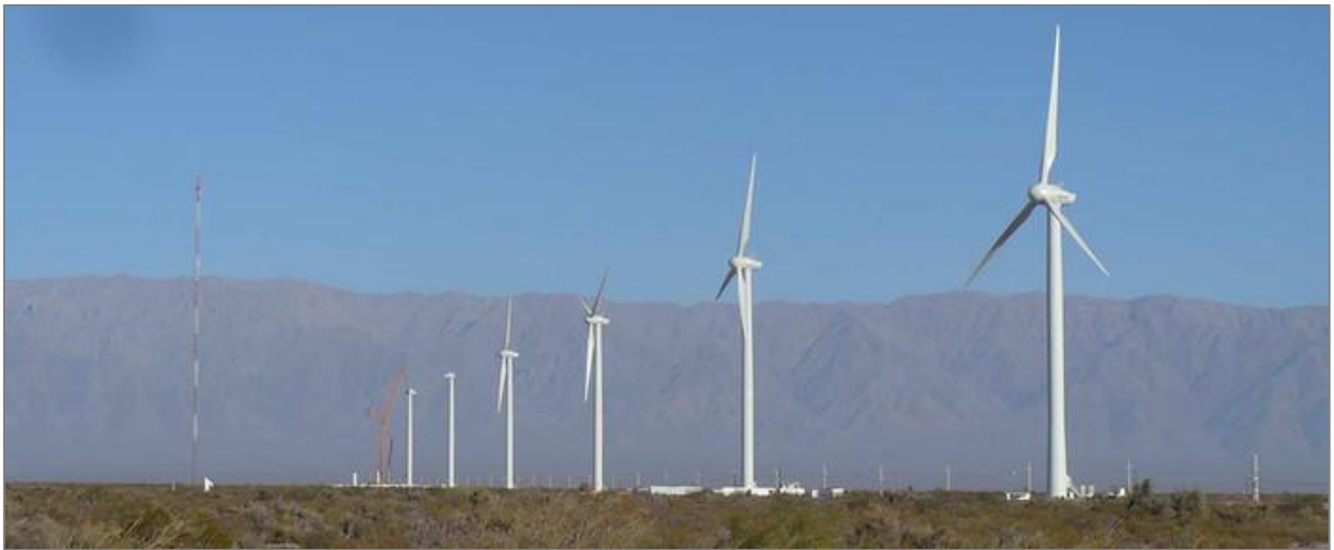
Vista de un parque eólico tipo en Argentina 27
