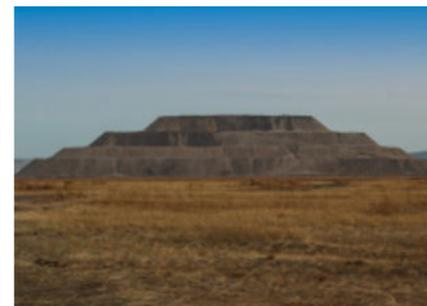
**Historia del depósito:** Método de disposición del material y edad del botadero, volúmenes depositados, secuencia de llenado, granulometría.
