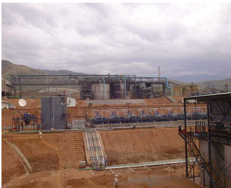
Figure 32 : Bio-lixiviation pour traiter le minerai de cuivre en Ouganda (Source : http://promine.gtk.fi/about/WorkPackage4.html ).
