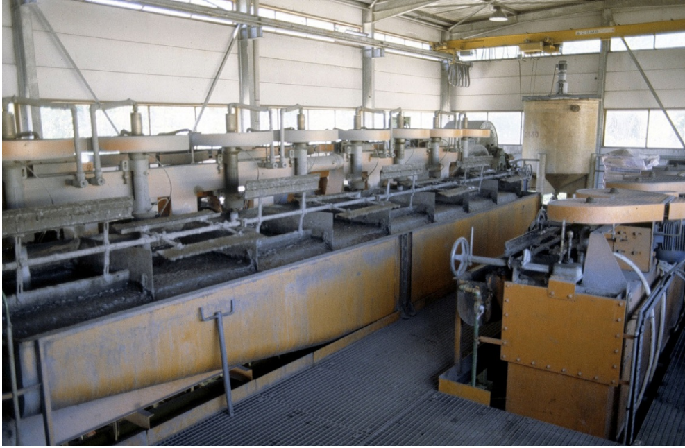
Figure 22 : Cellules de flottation de l'ancienne usine de traitement de la mine d'or du Bourneix, Haute-Vienne (Source : BRGM).
