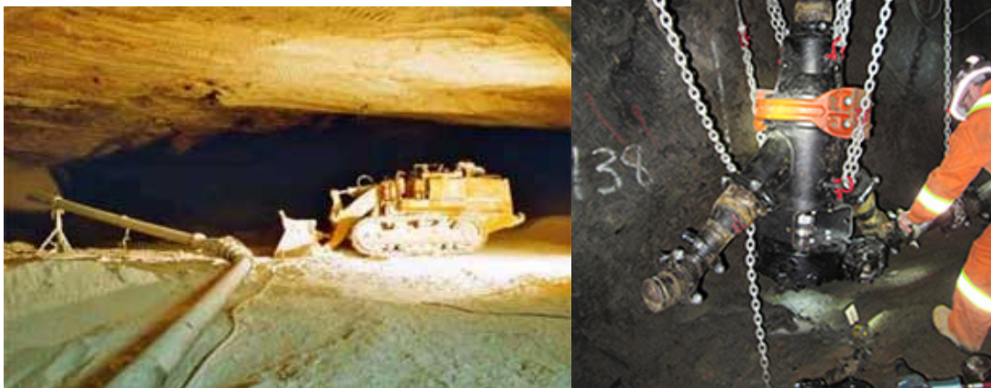
Figure 31 : Différentes mises en oeuvre de remblais en mines souterraines allemandes à gauche et américaines à droite (Source : www.victaulic.com et www.asse-archiv.de ).
