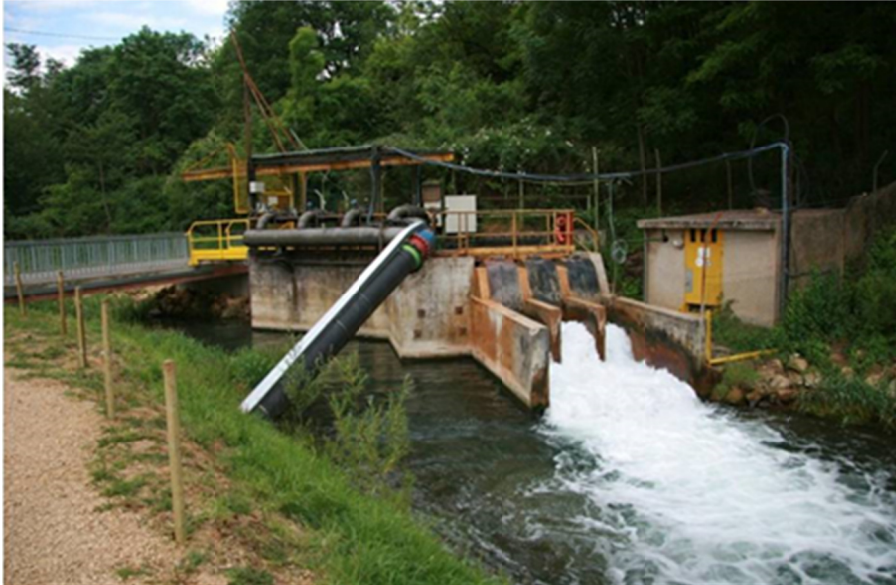
Figure 29 : Pompage d'exhaure des eaux de mine sulfatées, bassin ferrifère du Nord (galerie de la Paix à Knutange), 57 (Source : INERIS).
