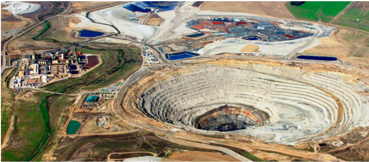
Figure 1 : Mine à ciel ouvert de cuivre-plomb-zinc de Las Cruces, en Espagne (Cliché : www.cobrelascruces.com ).
