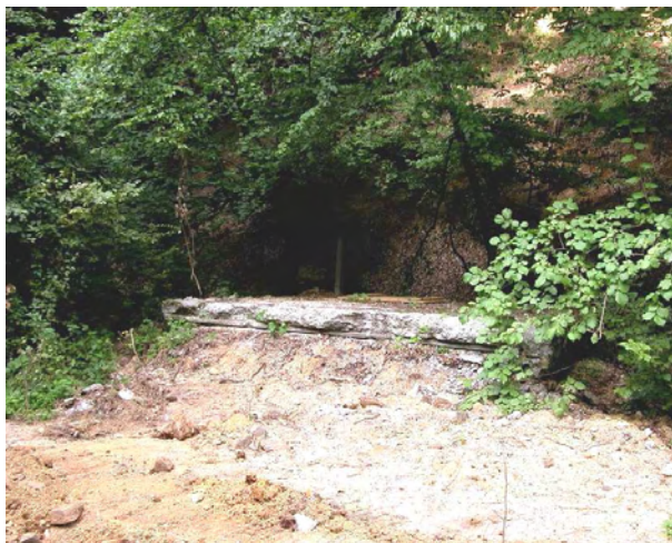
A Péter-Pál akna régi betonfedele
