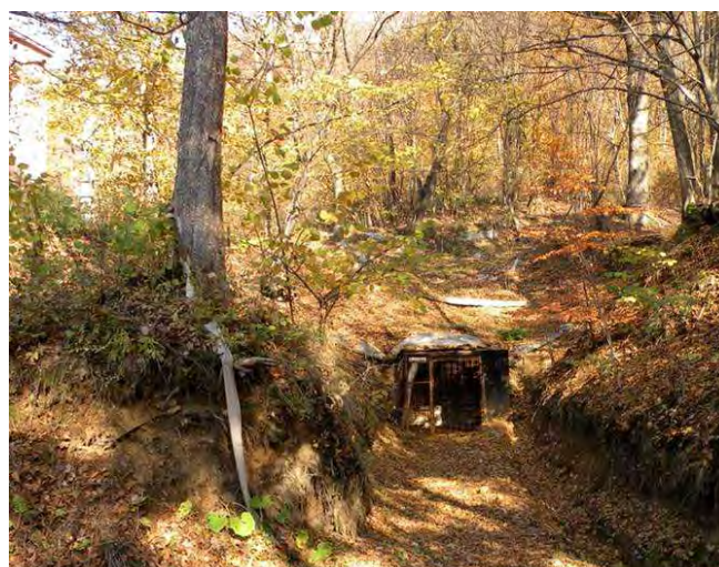
A Károly-táró kiszereelt, lefalazott bejárata
