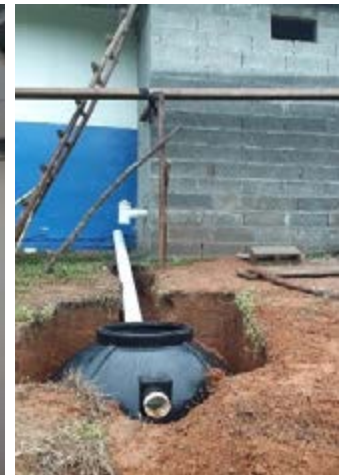
Mejoras al puesto de salud de Tanque séptico en Puesto Las Santa Rosa de Chagres. Cruces.
