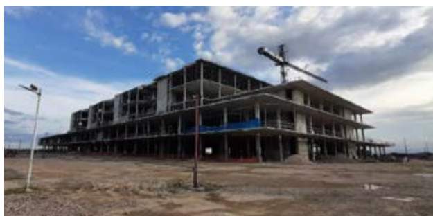
VISTA GENERAL NUEVO HOSPITAL AQUILINO TEJEIRA.
