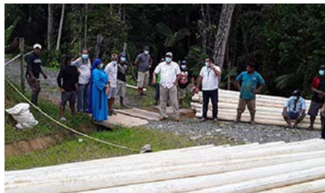
Entrega de tubería Calovébora, Santa Fe, tubería de julio 21.
