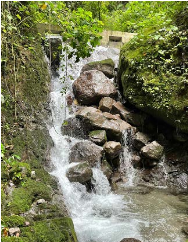
Vistas de área de represa construcción de acueducto rural en Maraca PROGRAMA DE AGUA POTABLE Y SANEAMIENTO EN AREA RURAL E INDIGENA DE PANAMÁ.
