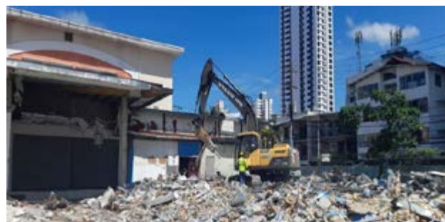
INICIOS DE TRABAJOS DE DEMOLICIÓN EN PROYECTO NUEVO HOSPITAL DEL NIÑO.
