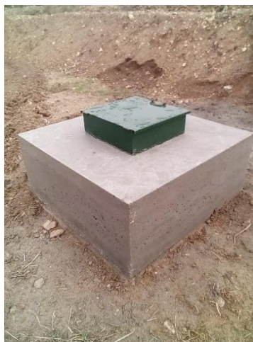
Estado después de la reparación (piezómetro 08.29.005)
