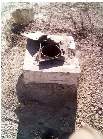
Figura 11. Ejemplos de trabajos de reparación de piezómetros.
