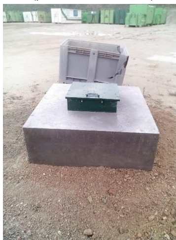
Estado después de la reparación (piezómetro 08.29.005)
