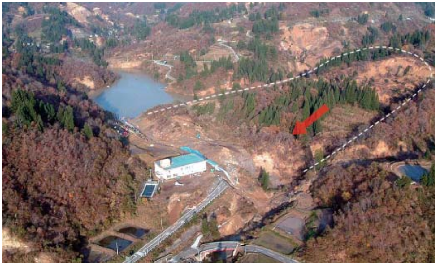
▲山古志村東竹沢地区で発生した河道閉塞状況〔写真提供／北陸地方整備局〕
