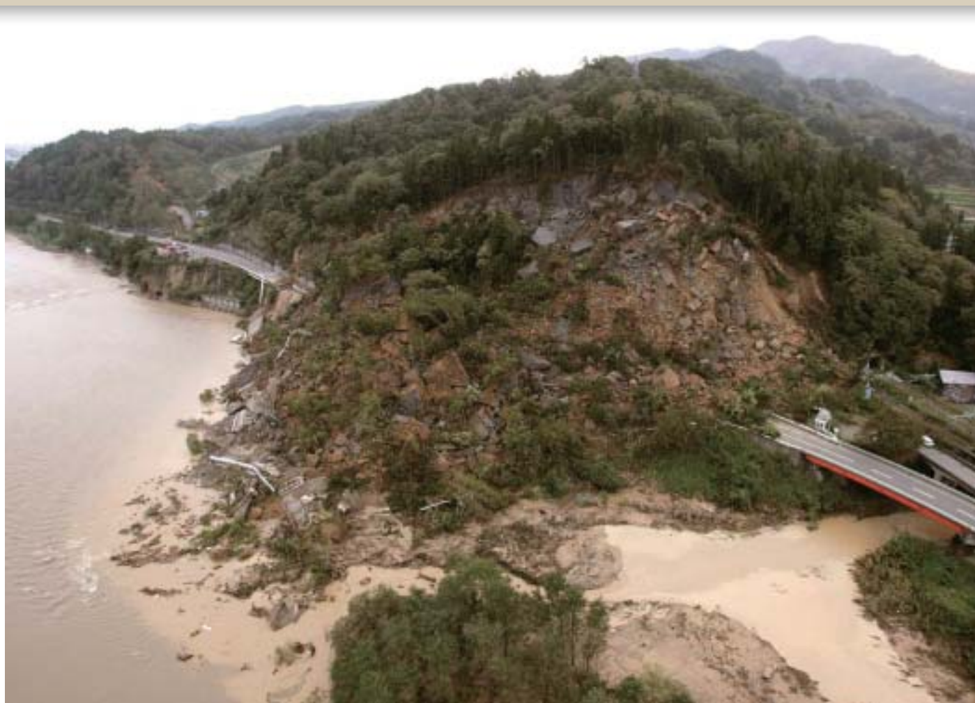
▲県道小千谷長岡線の土砂崩れ（長岡市妙見町）〔写真提供／共同通信社〕
