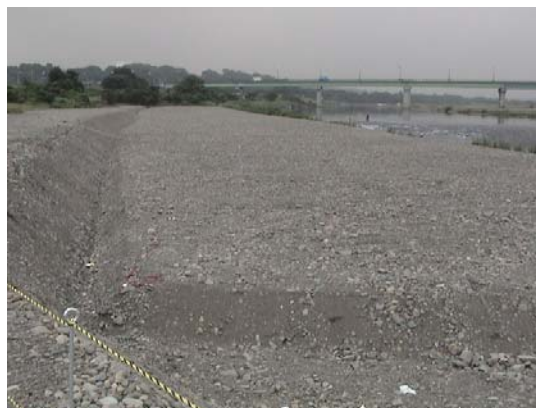
写真 8 - 3 H18 年度置き砂試験施工状況
