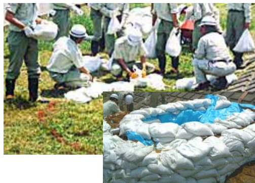
写真 9-7 水防訓練（月の輪工法）
