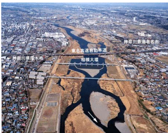
12km 相模大堰、東名高速自動車道橋梁
