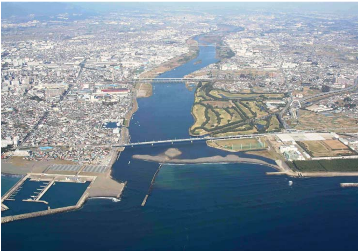
写真 8 - 2 河口部航空写真 (H17.11 撮影)
