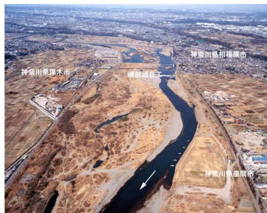
21km 磯部頭首工下流
