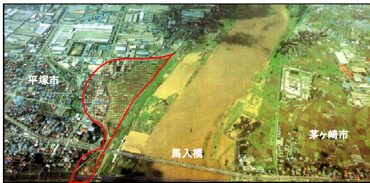
图 4 -15 昭和 57 年台風 馬入橋付近浸水図航空写真
