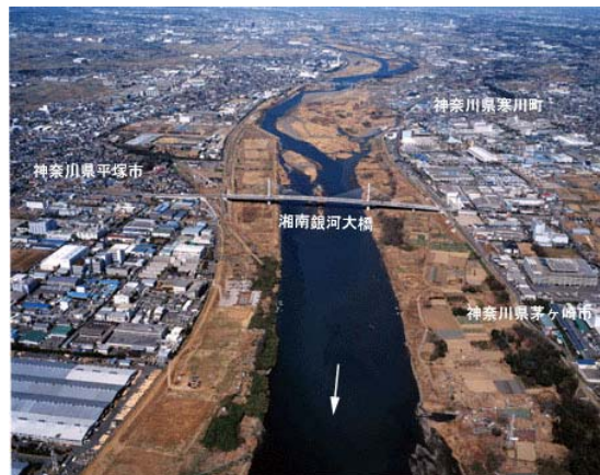
4km 湘南銀河大橋
