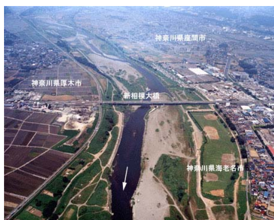
17km 新相模大橋
