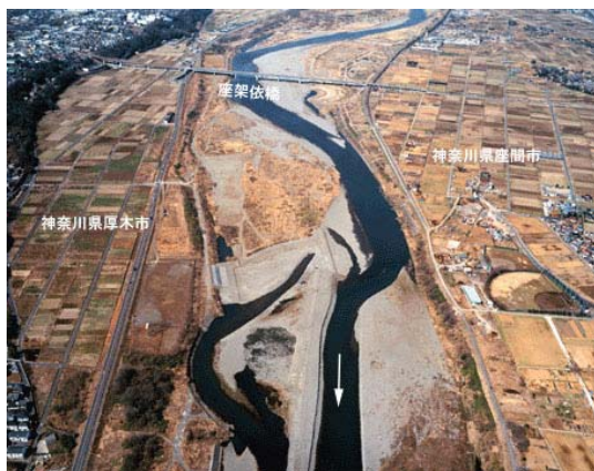
19km 座架衣橋下流
