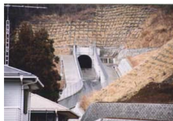
写真 4-7 嘯放水路吐口部（富士河口湖町浅川）
