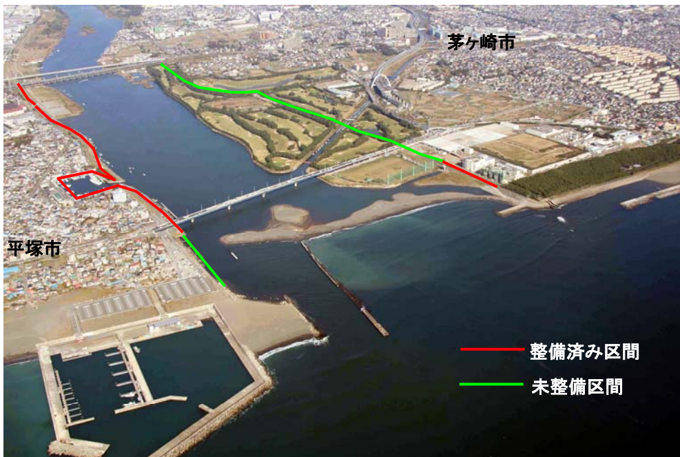
写真 4-9 高潮堤防整備状況
