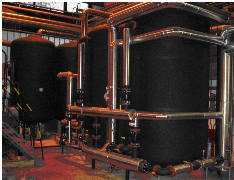
14. ábra Közbenső tartály és O 2 érzékelő
