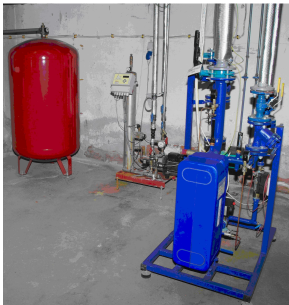
12. ábra ENA fűtővíz szivattyús vákuumgáztalanító berendezés a Kazincbarczikán (forrás: FLAMCO)
