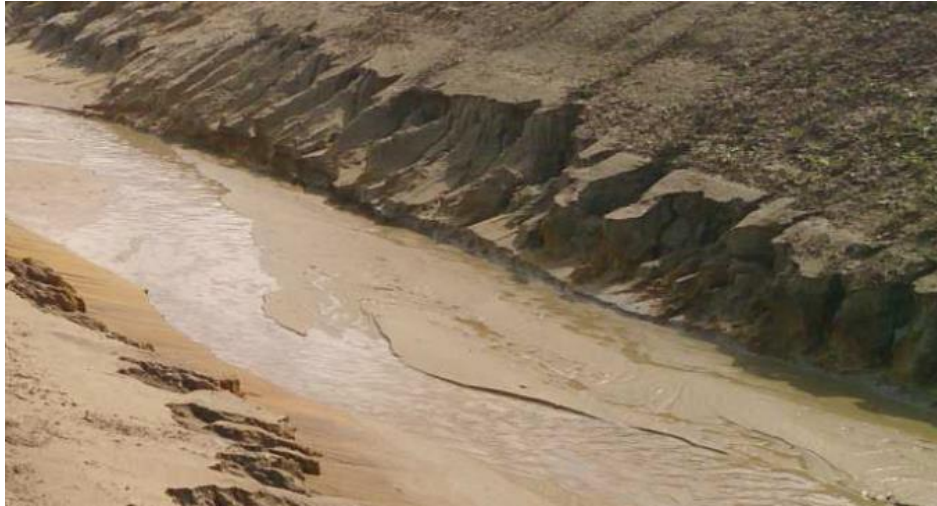
2.33. ábra. Talajvíz okozta rézsűkárosodás [Forrás: Szerzők]
