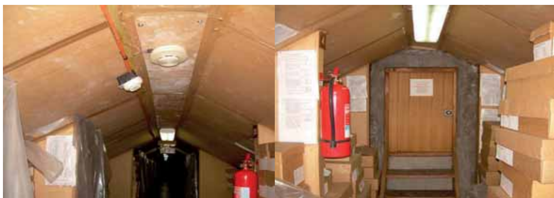
FIGURA 1. Sistemas de sensores de humo y extintores. FIGURA 2. Puerta de escape hacia el techo del Museo.
