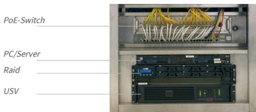
USVs sichern nicht nur gegen Netzausfälle, sondern schützen Netzwerkgeräte auch vor Schäden durch Spannungsspitzen und Unterspannungen
