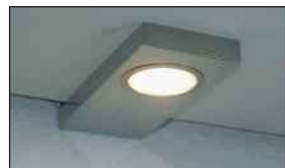
Kabel verbinden - fertig !
