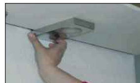
...bis die Leuchte gerade und fest anliegend unter dem Schrank sitzt.
