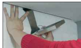
SpeedLight mit dem Fixierungsbügel am Rückwand-Hohlraum des Schrankes ansetzen.
