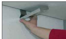
Fixierungsbügel zwischen Mauerwerk und Rückwand einschieben....
