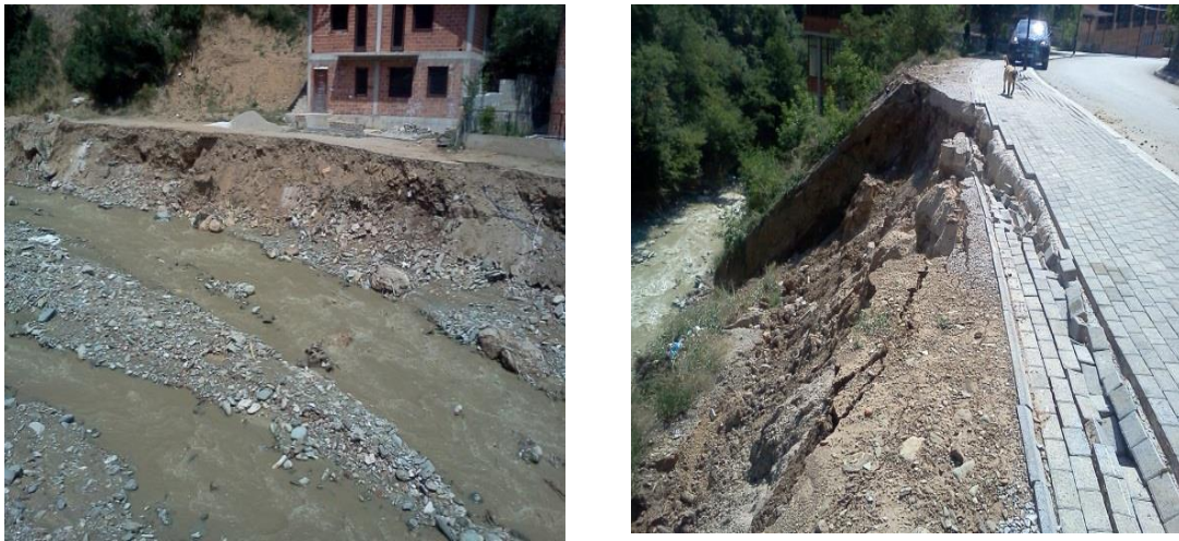
Слика 21 Река Пена - подривање на левиот и десниот брег пред влез во Тетово
