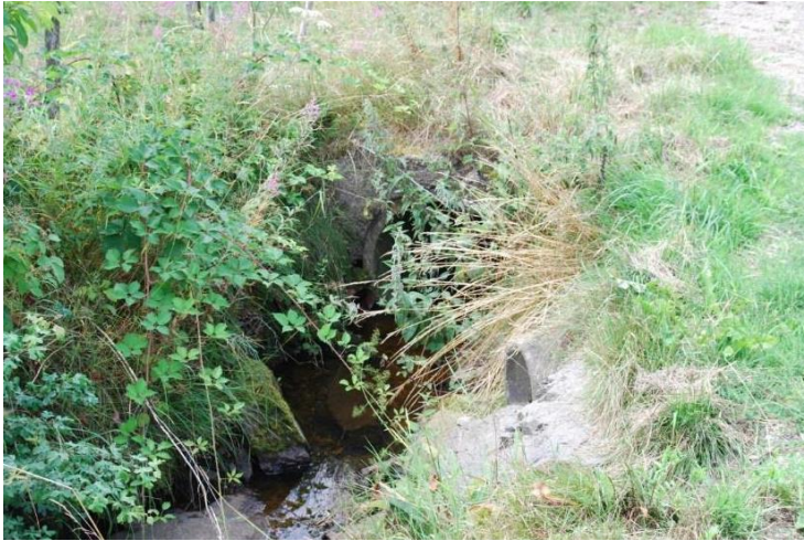
Offenes Gewässer am Übergang zur Verrohrung im Norden (Quelle: D. Liebert)
