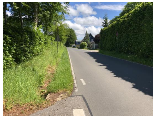
Abb. 4 – Entwässerungsgraben, offener Graben in Kirschensteinweg (Blick in Richtung Vennbahnradwegkreuzung)
