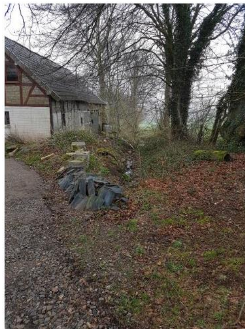
Entwässerungsgraben, offener Graben
