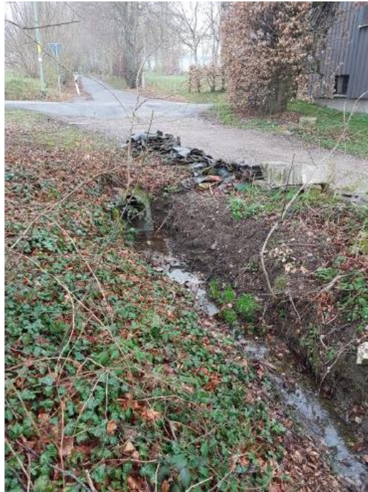
Entwässerungsgraben verrohrt, (Flurstück 360, Blick zum Kirschensteinweg) (Quelle: H. Berg & Partner GmbH)
