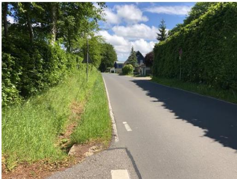
Entwässerungsgraben, offener Graben in Kirschensteinweg (Quelle: H. Berg & Partner GmbH)
