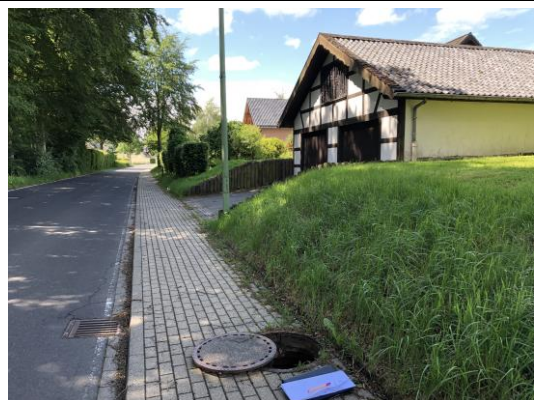
Abb. 3 – Entwässerungsgraben im Gehweg des Kirschensteinwegs, verrohrt (Blick in Richtung Eupener Straße)
