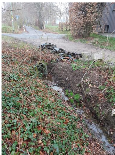
Abb. 5 – Entwässerungsgraben verrohrt, (Flurstück 360, Blick zum Kirschensteinweg)
