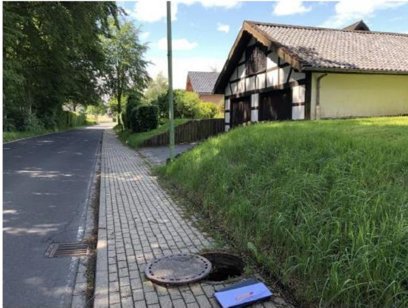
Entwässerungsgraben im Gehweg des Kirschensteinwegs, verrohrt (Quelle: H. Berg & Partner GmbH)
