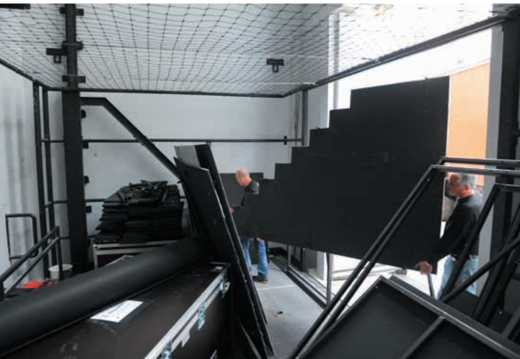
Grâce à cette plateforme élévatrice, les 8 tonnes de matériel sont acheminées aux différents niveaux de l'Opéra.
