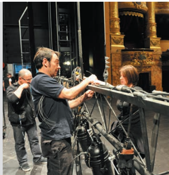
Avant l'arrivée du décor, les électriciens installent près de 140 projecteurs sur les 80 cintres mobiles que comporte la cage de scène.
