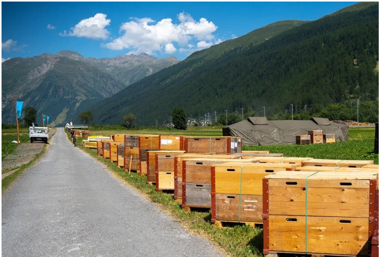
Foto 18: Materialpaletten, die von der befestigten Strasse her deponiert wurden (rechts) und Weg mit Bodenschutzrosten (links) (Fotograf*in unbekannt)
