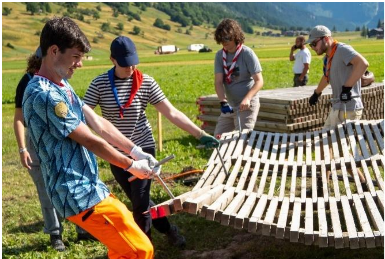
Foto 20: Verlegen von Bodenschutzrosten (Till Böhringer / Pallas)
