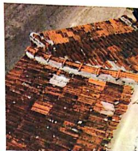
Figuras 07 e 08: Argamassa de cimento colocada de maneira improvisada no encontro entre a alvenaria e o telhado e também no espigão do telhado.
