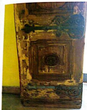
Figura 03: Porta descascada do pórtico lateral.
