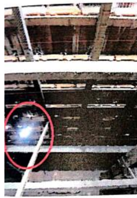
Foto 34 e 35. Telhado Nave Principal – Frestas nas telhas. Nota problemas no beiral.
