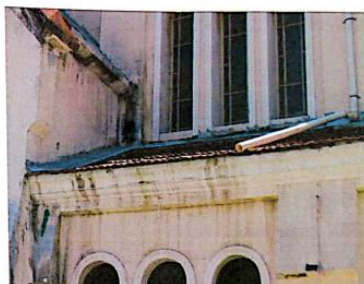
Figuras 09 e 10: Tubulação de PVC colocada de maneira improvisada para captar a água da chuva.
