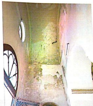
Figura 04: Paredes e teto descascados e emboçados do pórtico lateral.
