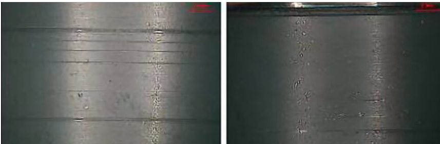
Abb. 37: P2-Gleitlager, Riefen in der Lauffläche
