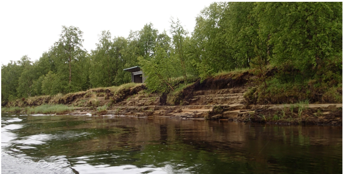
Kuva 8. Muoniojoen eroosion syövyttämää rantatörmää Rukomasaaren lounaisrannalla.
