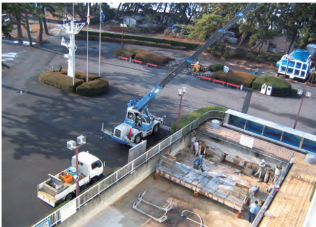
写真 4 造波函の検査
