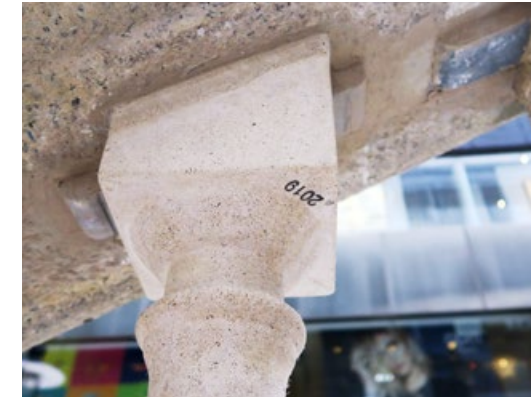
26 新造的水泥欄杆柱在暗處蓋上製作年份「2019」的印章
