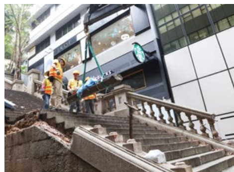
29 工程人員沿用了古蹟原先的加固方法，將 U 型不銹鋼構件，裝嵌於新造的水泥欄杆柱後，才重新接駁及加固損毀了的花崗石扶手。
