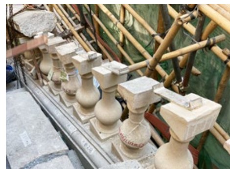
29 工程人員沿用了古蹟原先的加固方法，將 U 型不銹鋼構件，裝嵌於新造的水泥欄杆柱後，才重新接駁及加固損毀了的花崗石扶手。
