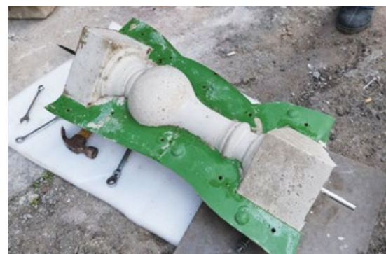
25 項目團隊檢查及監督新水泥欄杆柱的製作，確保新欄杆柱與原來欄杆柱的外型、物料、顏色、質感及工藝技術互相融合。
