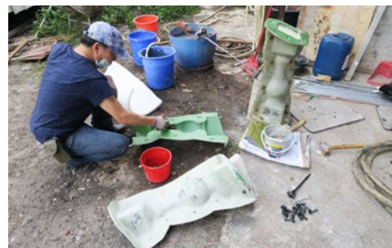
25 項目團隊檢查及監督新水泥欄杆柱的製作，確保新欄杆柱與原來欄杆柱的外型、物料、顏色、質感及工藝技術互相融合。
