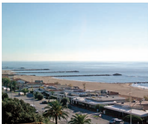
Figura 3: Marina di Massa: sistema di difesa basato su celle costituite da pennelli uniti all'estremità da una scogliera soffolta.
