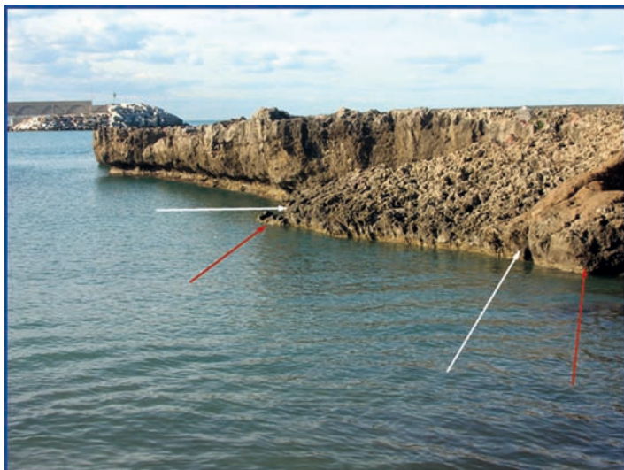
Figura 17: Ancora sul fianco Nord di Baia Crepatura si può osservare l'interruzione netta del solco di battente a iniziare da un grande blocco di calcareniti adagiato su un fianco, come mettono bene in evidenza le vaschette di corrosione della superficie non più orizzontale; sembra evidente che questo grande blocco sia franato per «sostegno manco», cioè scavato al di sotto da un solco di battente, ormai non più esposto, del tipo di quello che mina la stabilità del tratto più interno del fianco Sud: le frecce bianche delimitano il maggiore dei blocchi franati, quelle rosse due blocchi minori.
