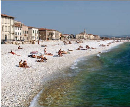
Figura 5: Marina di Pisa: spiaggia in ghiaia realizzata congiuntamente all'abbassamento delle scogliere parallele.
