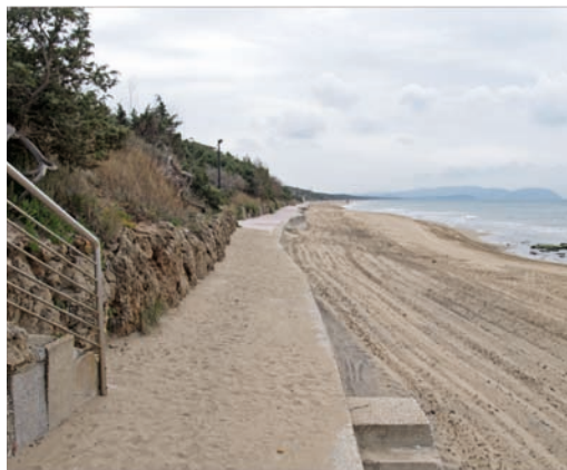
Figura 7: Passeggiata recentemente costruita al piede della duna su di un tratto di spiaggia posto a sud di San Vincenzo.
