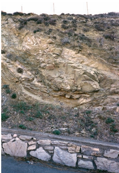
Figura 4: Un vistoso esempio di arenaria "tipo Macigno" imballata nella Unità di Canetolo, fortemente deformata, affiorante lungo la trincea stradale di accesso all'Istituto Tecnico secondario.
