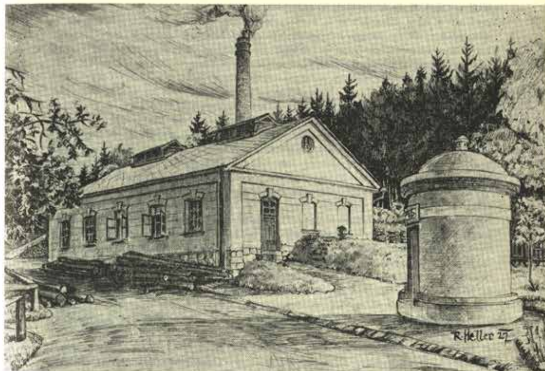
Vodárna pro Nový Jičín v Bernarticích nad Odrou v r. 1927
