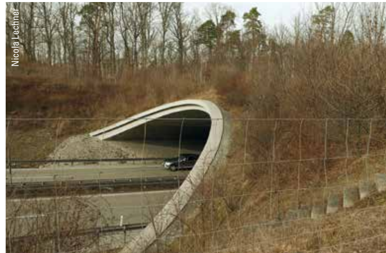
Grünbrücke über die B 295 zwischen Leonberg und Renningen
